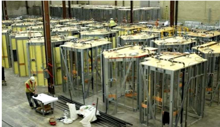
Banheiros prontos com o uso do BIM (makebim)
