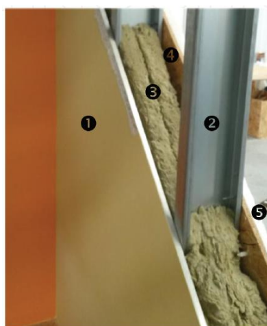
Figura 13 - Exemplo de aplicação dos materiais em uma seção transversal de parede em LSF
