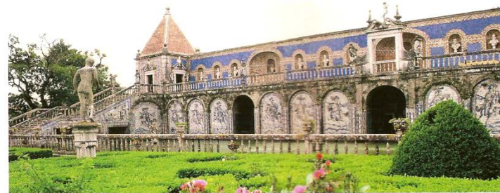
Palácio dos Marquezes de Fronteira - Galeria dos Reis e Jardim Grande
