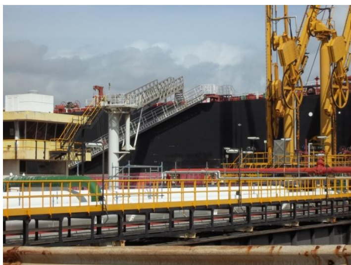
Ilustração 9 - Escada hidráulica do cais colocada com o navio de crude já bastante descarregado
