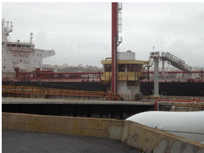
Ilustração 8 - Escada hidráulica do cais colocada com o navio de crude a iniciar a descarga
