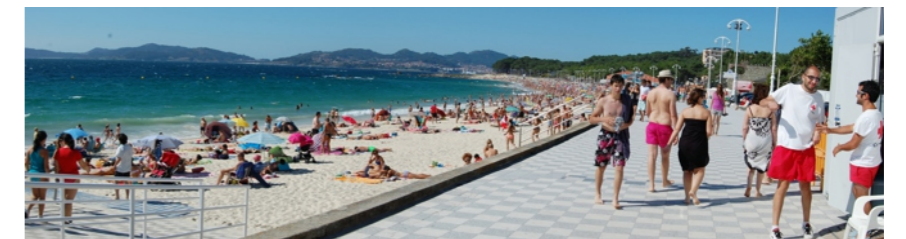
OBRAS EN ZONA DE PLAYA
