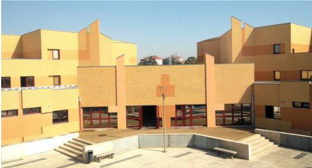
Figura 16. Entrada principal do edifício de alojamento dos alunos.
