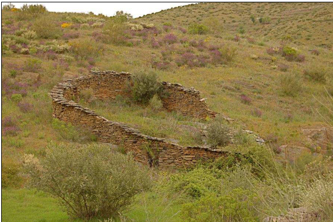
Figura 40. Vista geral do muro de Vale de Moinhos.
