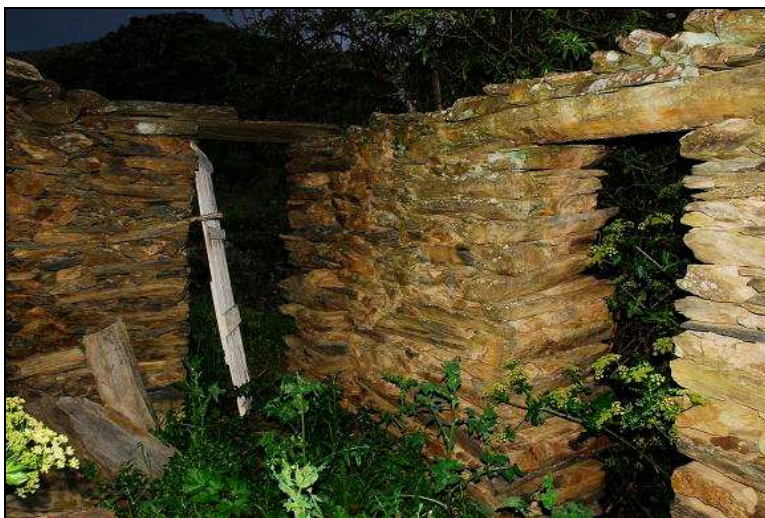
Figura 64. Porta e anexo interior do mesmo muro.
