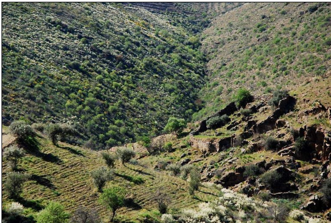
Figura 36. Vista da implantação do muro da Quinta da Leda.
