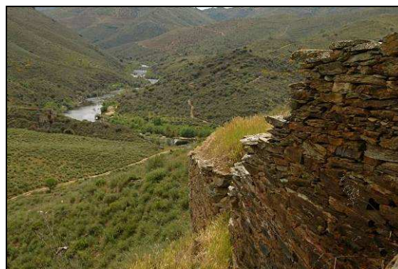
Figura 26. Pormenor da face exterior do muro da Tapada da Penascosa.
