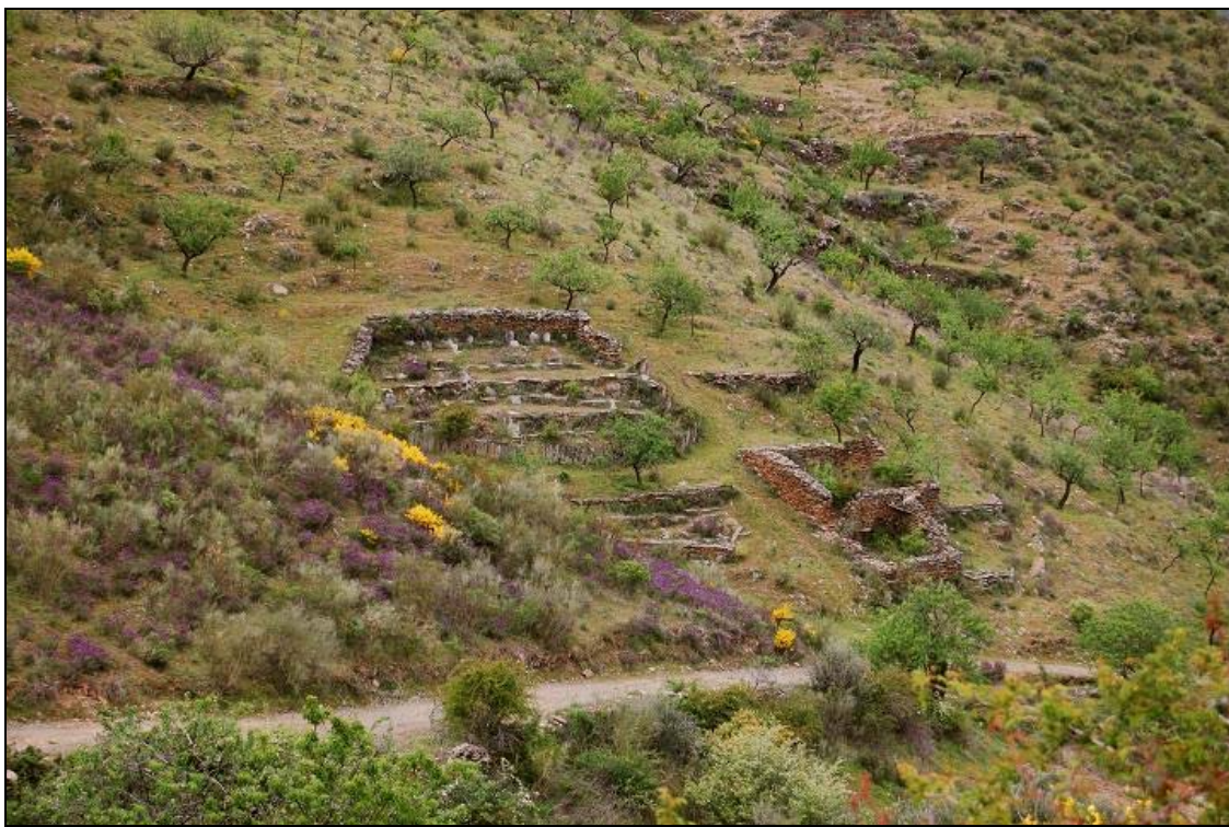
Figura 58. Vista geral do muro I do Orgal.
