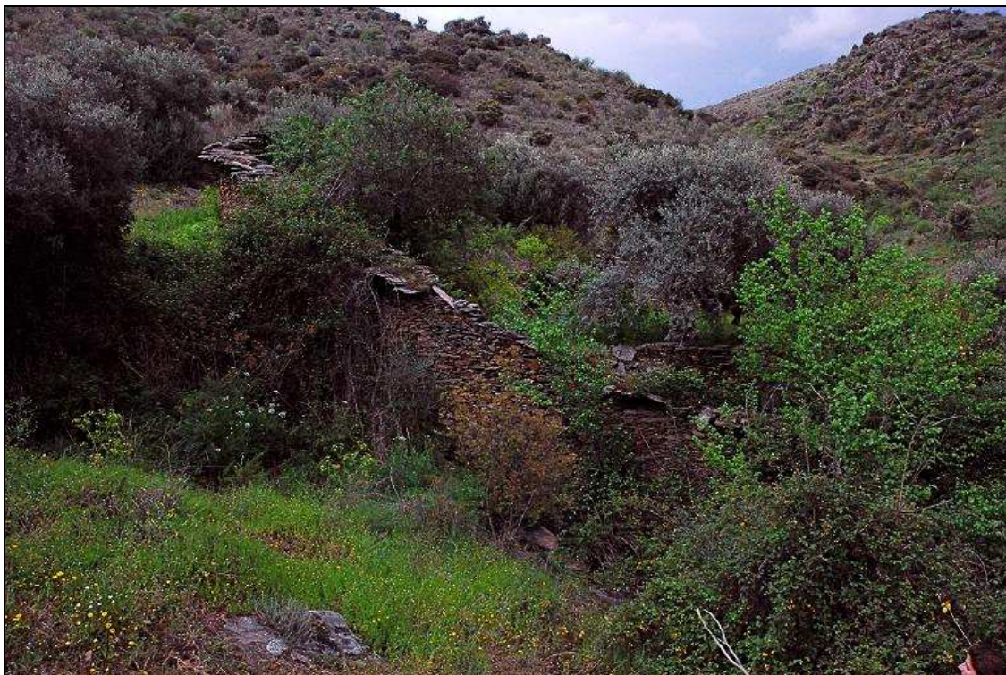
Figura 62. Face exterior do muro da Ribeira do Muro.
