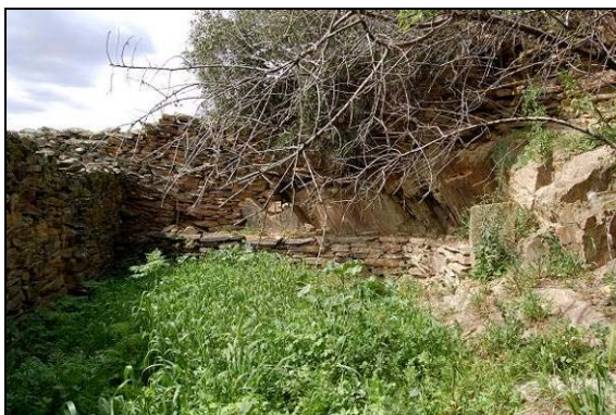
Figura 16. Interior do anexo da Ribeirinha, observando-se aí a estrutura sub-circular que aí se encontra.
