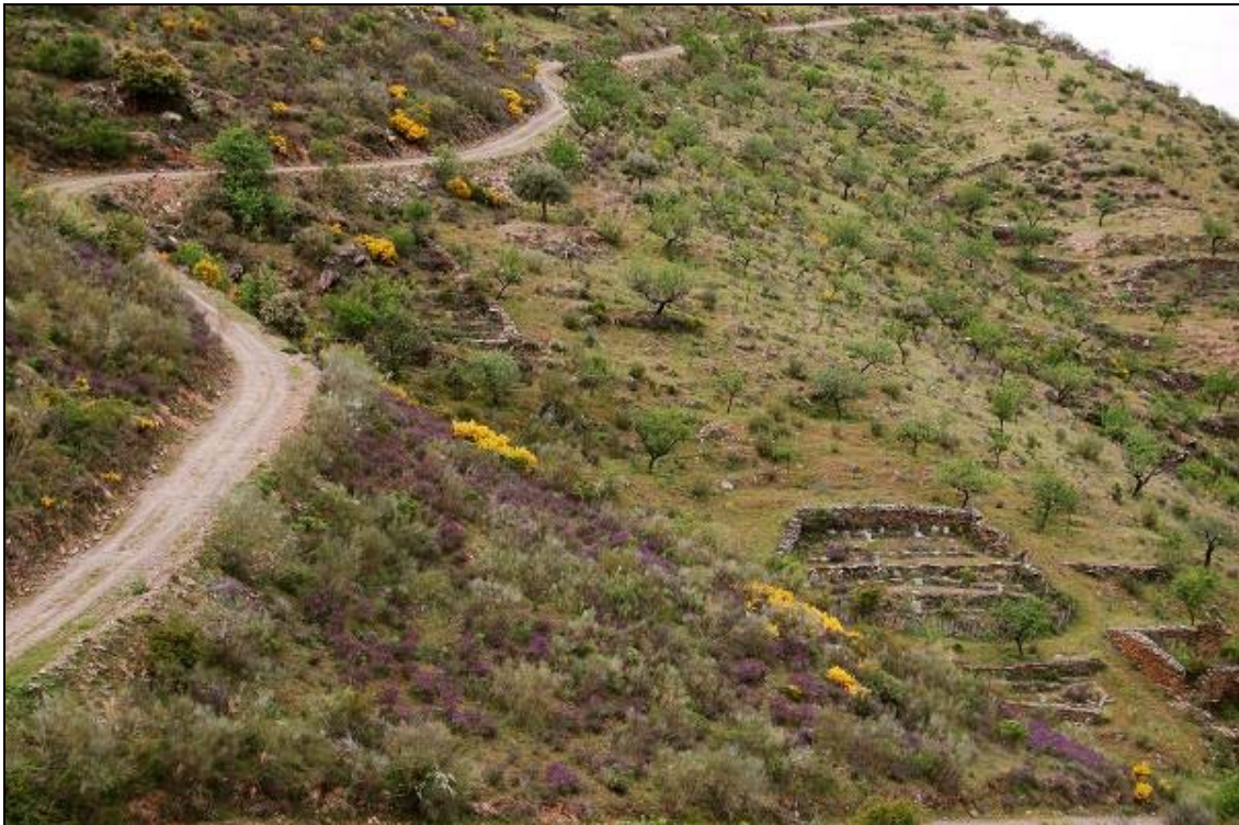
Figura 59. Vista geral dos muros do Orgal.
