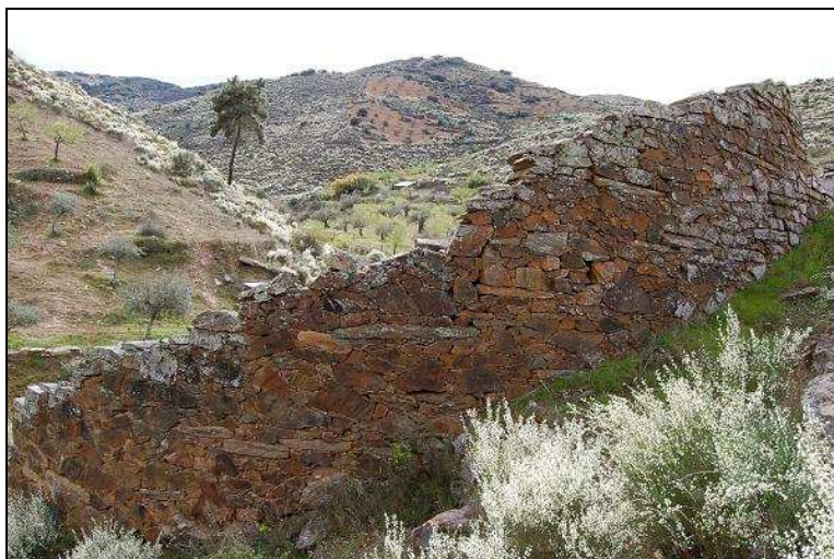
Figura 29. Face exterior do muro da Volta da Picanceira.
