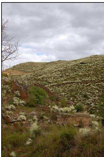
Figura 28. Vista de ambiente do muro da Volta da Picanceira.
