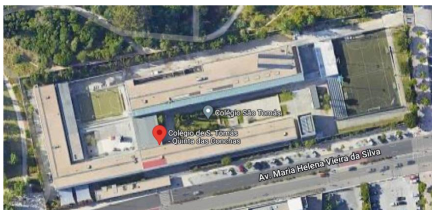
Figura 2 - Vista área do CST
