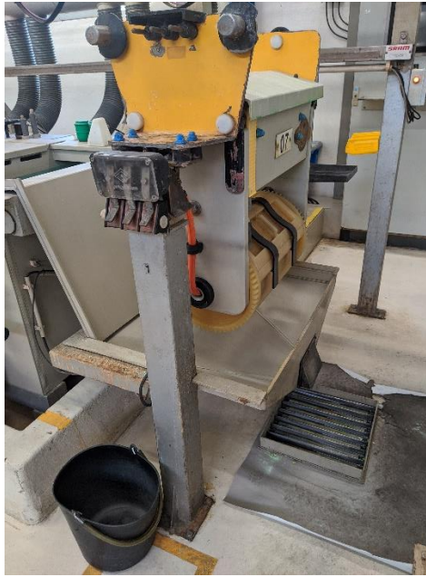
Figura 23: Zona de carga e descarga do tambor das peças para niquelar.
