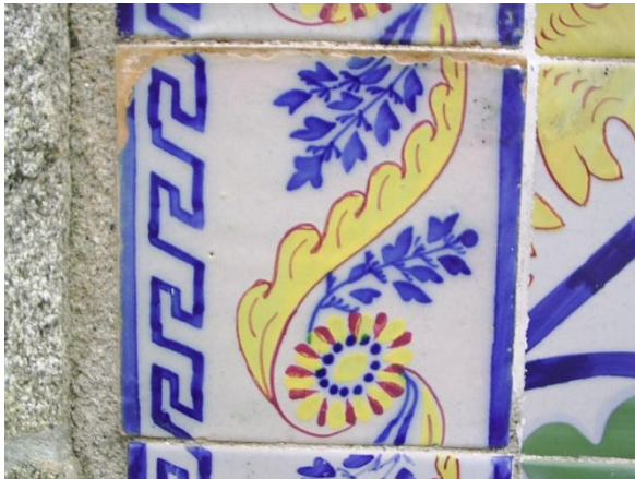
Lacuna de vidro consolidada que não avançou desde a intervenção.
