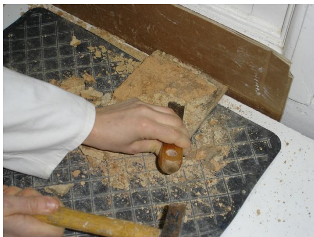
Remoção das argamassas do tardo
