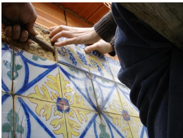
Remoção dos azulejos da fachada
