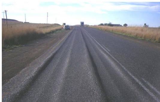
Figura 2.4 - Pavimento de EBVT com rodeiras (Pinard, 2006)
