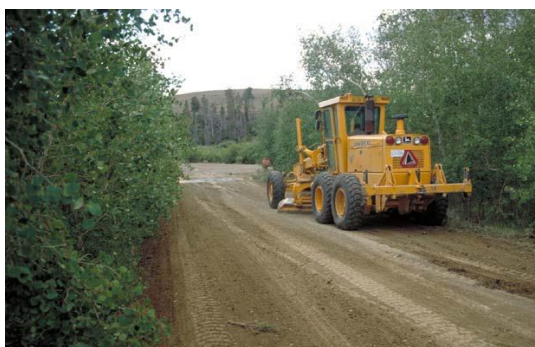
Figura 4.8 - Manutenção de um pavimento granular com motoniveladora (MAI, 2005)
