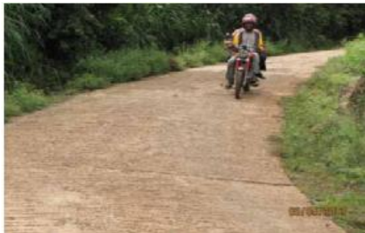
Figura 2.21 - Exemplo de pavimento de betão (MTPW, 2013 a)
