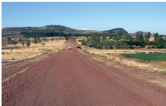
Figura 2.16 - Exemplo de estrada com revestimento de cascalho (ERA, 2011)
