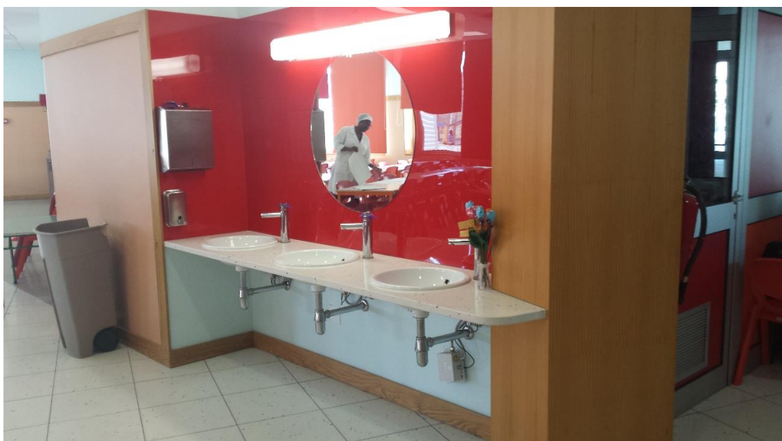
Figura 23 – Lavatórios da cantina da escola do 1.º CEB
