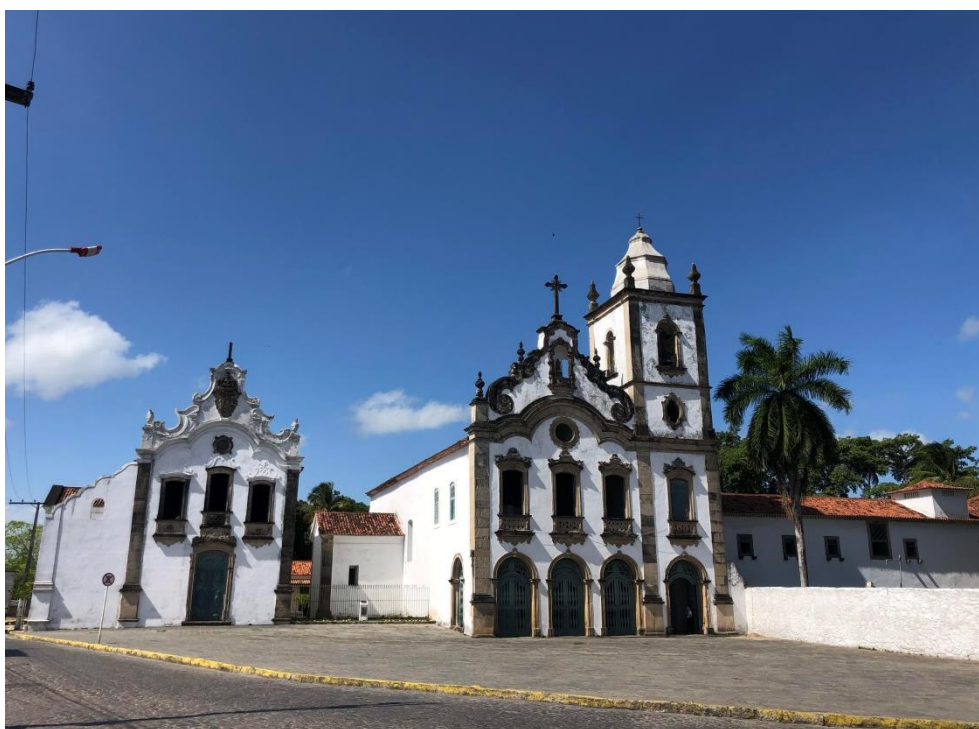
Figura 28: Convento e Igrejas da Ordem de São Francisco em Marechal Deodoro. Fonte: Autor (Arquivo Pessoal).
