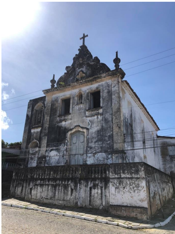
Figura 31: Igreja de Nossa Senhora do Amparo dos Homens Pardos.
