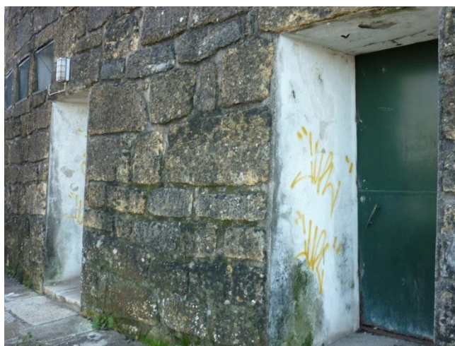
Figura 53 – Casas de banho públicas do Convento de Cristo
