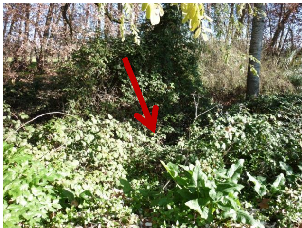
Figura 24 – Entrada de Tomar pela EN 110: Inexistência de limpeza do Rio Nabão
