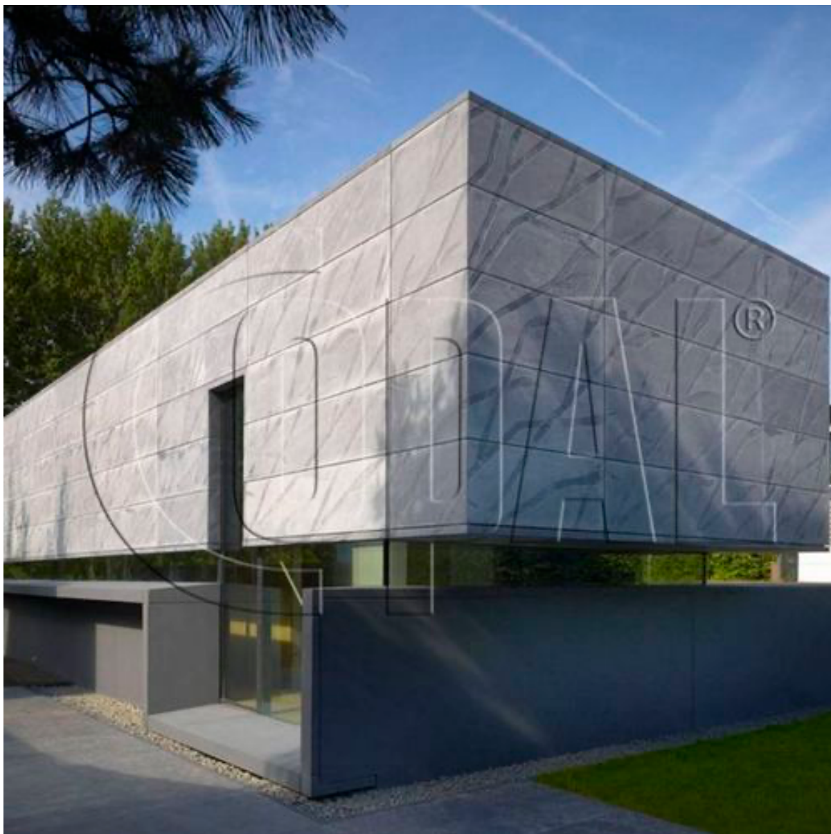
Figura 32 - Revestimento de fachada com painel M-Tek (fonte: Google imagens)
