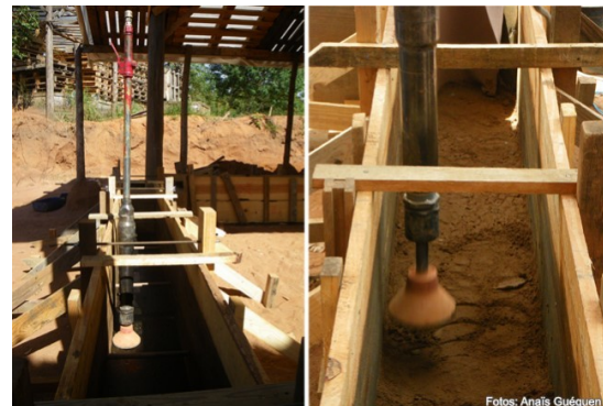
Figura 21 - Compactação mecânica da taipa (Silva, 2015)
