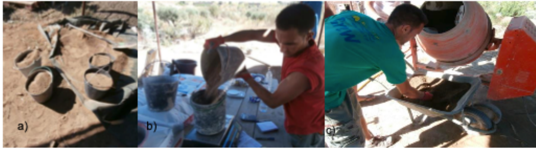
Figura 15 - A) e B) Dosagem dos materiais; C) Mistura dos materiais utilizando uma betoneira elétrica. (Silva, 2015)
