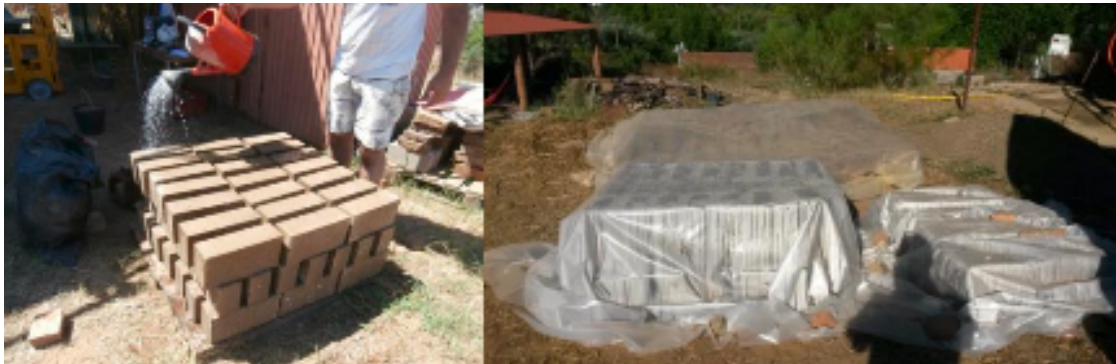
Figura 17 - Cura dos blocos: blocos tapados com lona plástica após rega com água (Silva, 2015)
