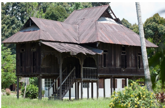
Figura 7 - Arquitetura Vernacular da Malásia
