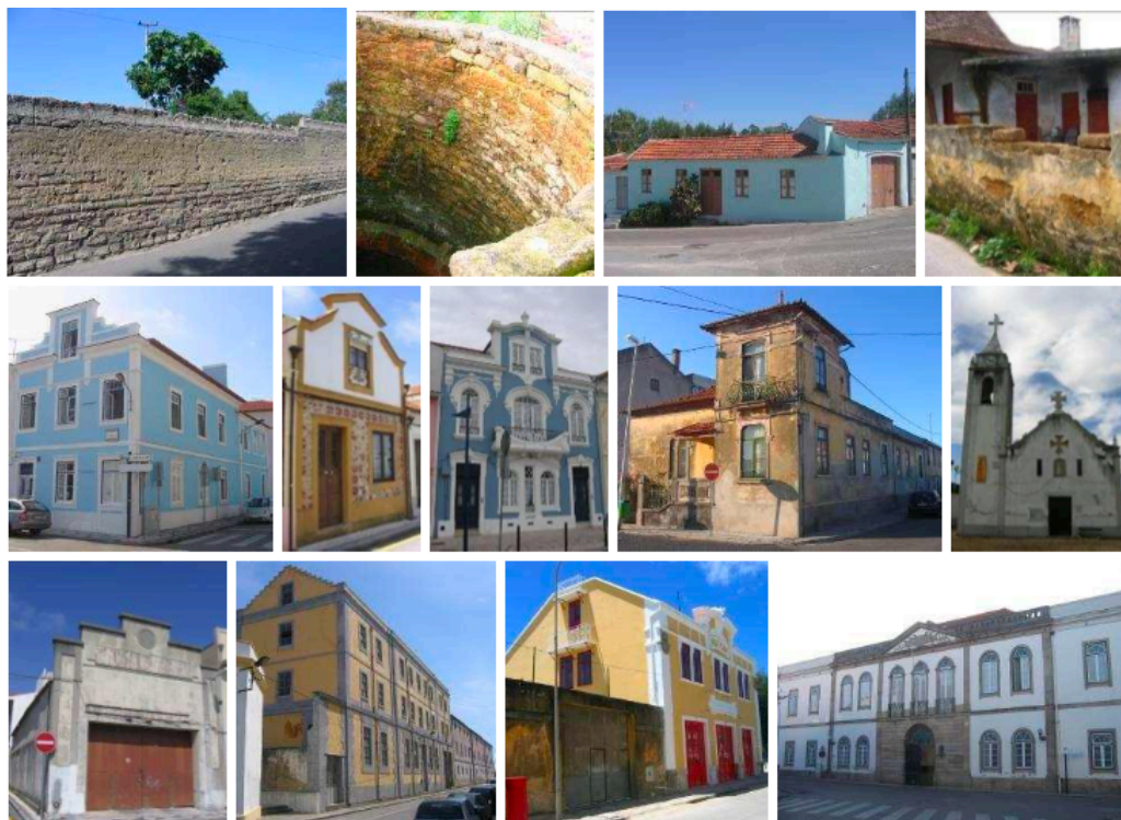
Figura 11 - Exemplos de construções em adobe existentes no distrito de Aveiro (Varum, Costa, Silveira, Oliveira, & Figueiredo, 2010)
