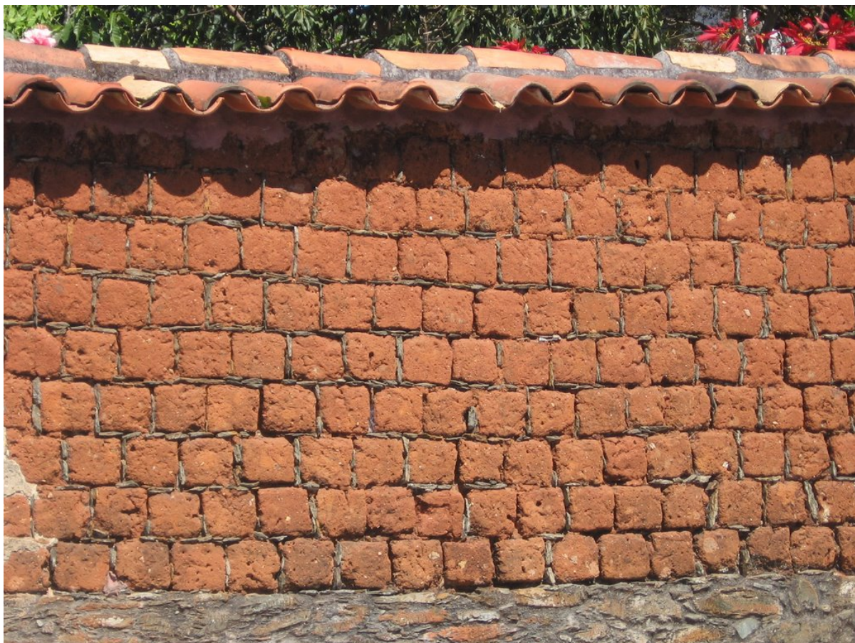
Figura 13 - Alvenaria de adobe (Fonte: Google Imagens)
