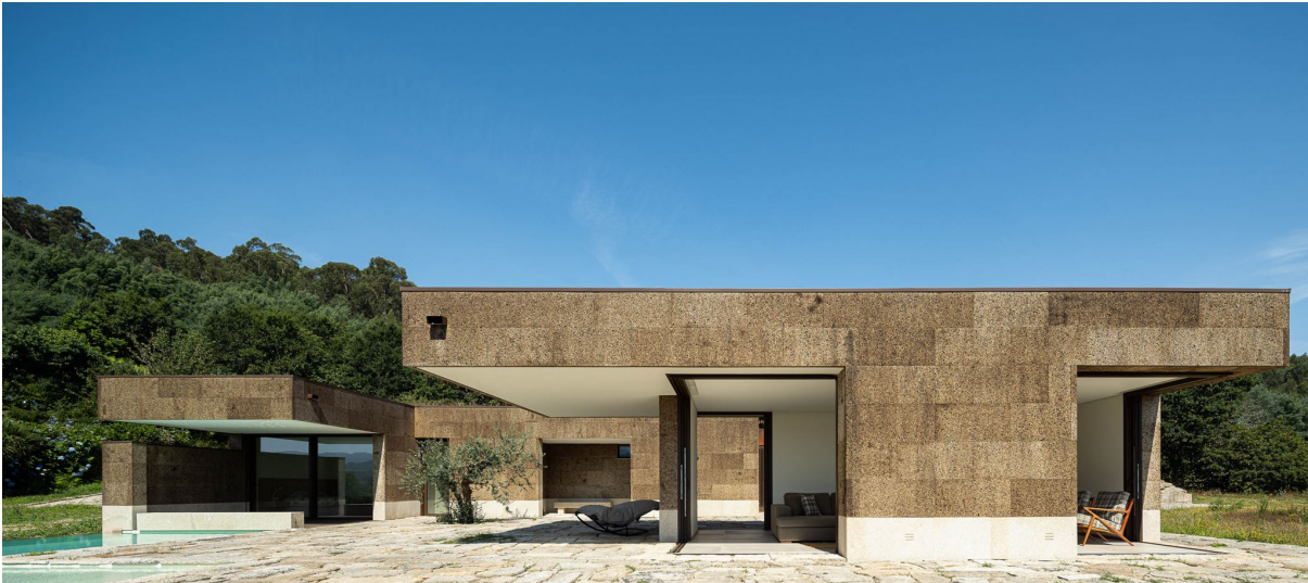
Figura 37 - Caso de estudo de moradia com revestimento em cortiça. (Amorim cork solutions, junho 2025.)
