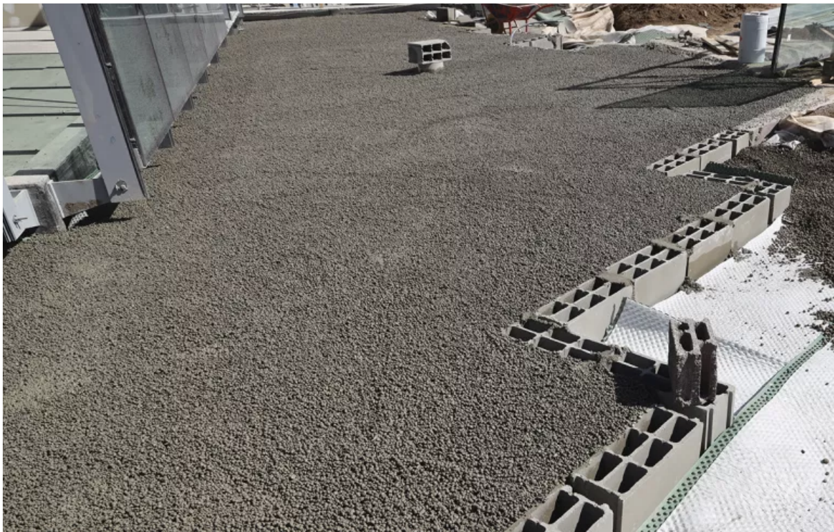
Figura 28 - Pavimento executado com Leca (Fonte: Google imagens)
