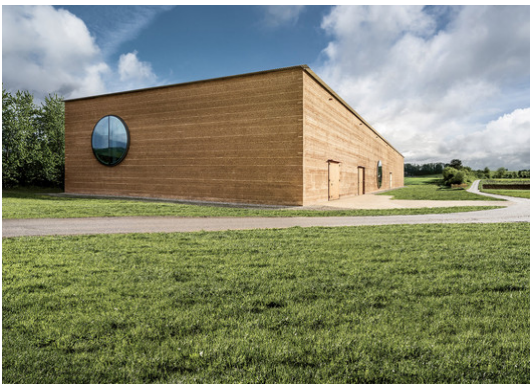
Figura 18 - Novo edifício da empresa Ricola, Suíça (2012) (Silva, 2015)
