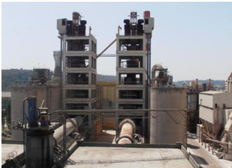
Figura 7: Torre de ciclones do forno, um e dois.
