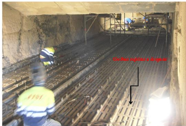
Figura 48: Arrefecedor em manutenção.
