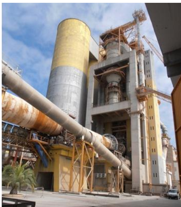
Figura 8: Torre de ciclones do forno 3, com respetivo pré-calcinador, silo de farinha e forno.
