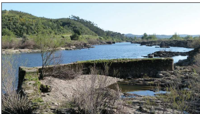
Figura 23. Pesqueira junto ao bairro dos pescadores em Ortiga Fonte: Marques, 2013.
