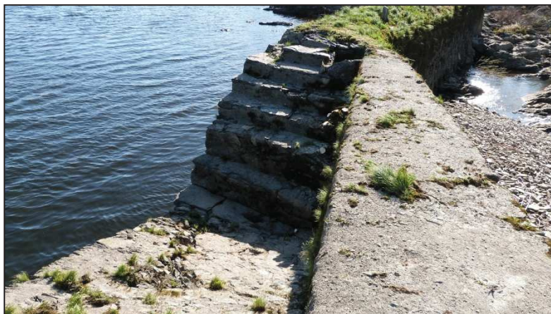
Figura 22. Pesqueira junto ao bairro dos pescadores em Ortiga Fonte: Marques, 2013.
