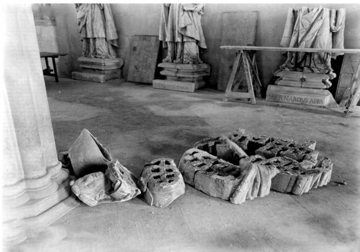
Fig. 51 - Colocação das esculturas em barro cozido na Sala do Capítulo em 1930. (Fonte: DGEMN)
