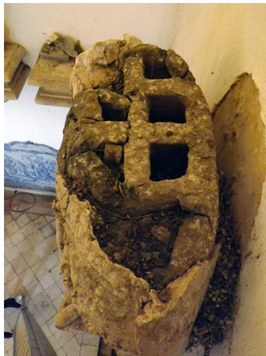
Fig. 31 - Acumulação de guano e sujidade proveniente dos pombos no tecto superior da escultura do rei D. Sebastião.
