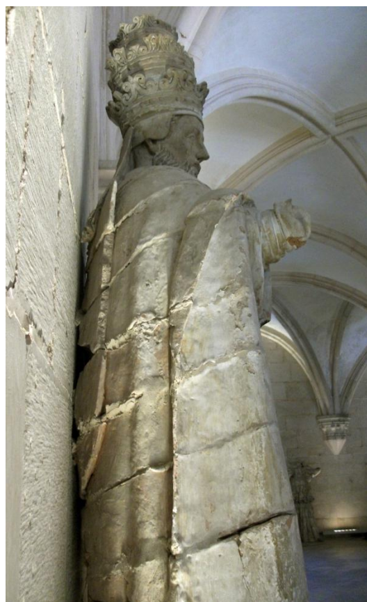
Fig. 11 - Escultura seccionada em taceiros.
