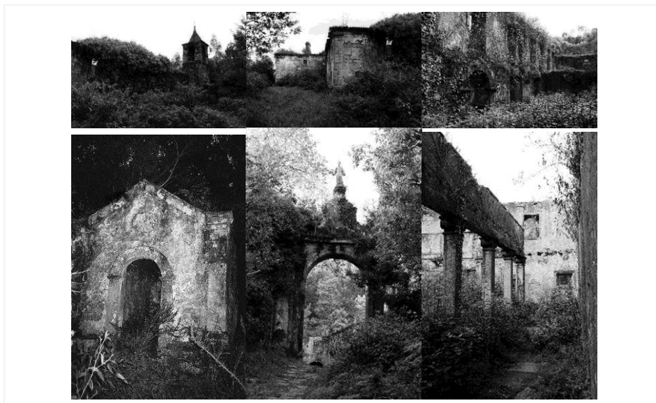
Quadro de Fotografias 88 – Convento de São Francisco do Monte
