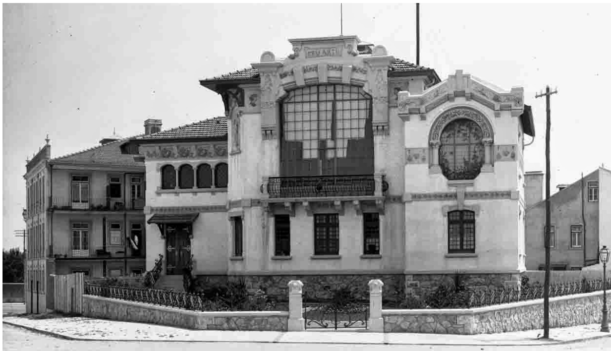
Fig. 112 - Casa-atelier José Malhoa e Casa António Pinto da Fonseca Mota. Esta fotografia é anterior à colocação da decoração azulejar na fachada, provavelmente do ano 1908 ou 1909 e seguramente posterior a 1905, foto de Paulo Guedes (1886-1947) (AFML).
