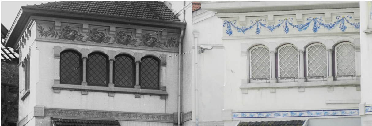
Fig. 113 - Aspecto da decoração original a fresco e da actual em azulejo, no corpo lateral onde se encontrava a porta de acesso à moradia .
