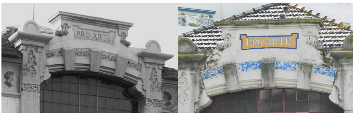
Fig. 122 - Versão original do frontão principal e a realizada em azulejo. Quer as palavras PRO ARTE, quer as ramagens de flores diferem ligeiramente.
