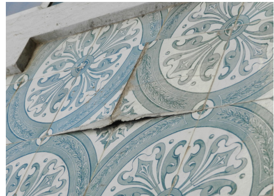
Fig. 265 - Enfolamento do painel. Rua Pinheiro Chagas nº 37.
