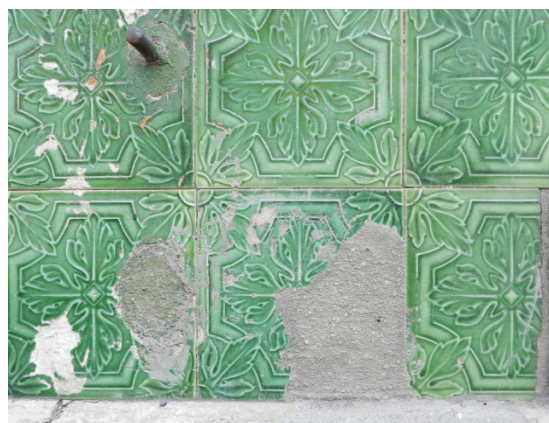
Fig. 262 - Preenchimento de lacunas com argamassa de cimento Portland. Avenida Defensores de Chaves nº 20.
