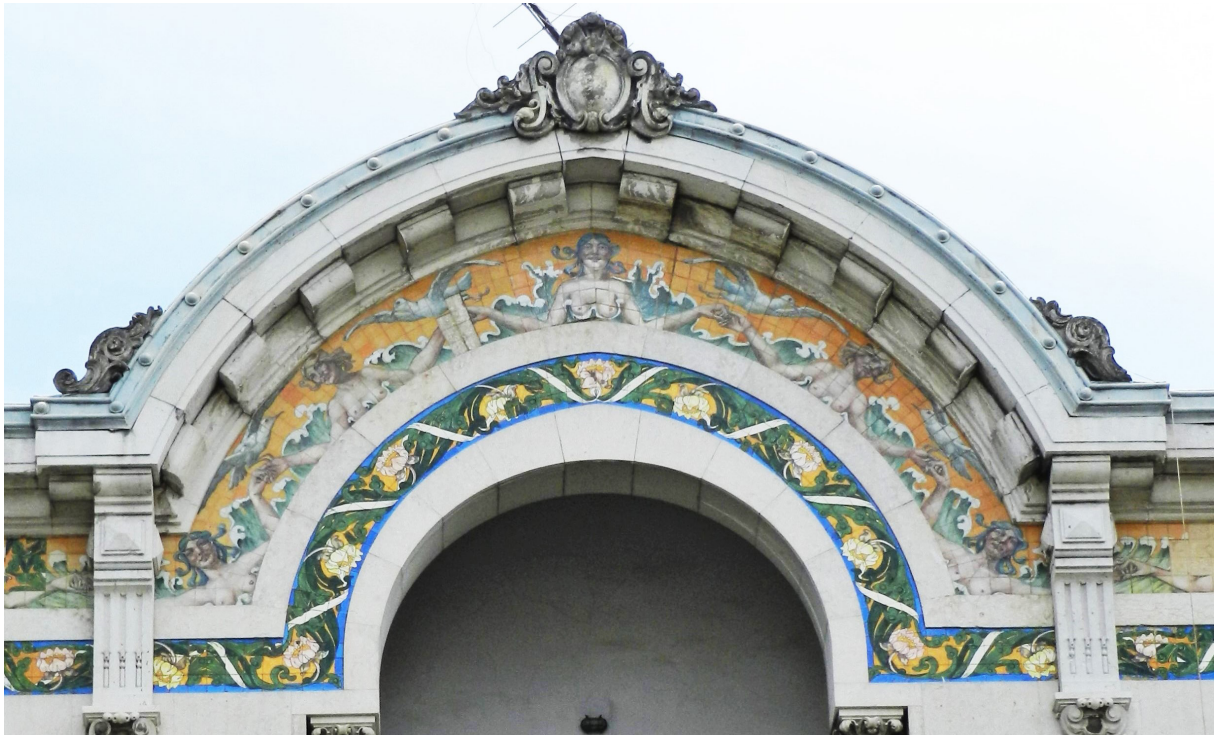
Fig. 206 - Pormenor onde se podem ver os dois frisos coordenados, no remate do edifício.
