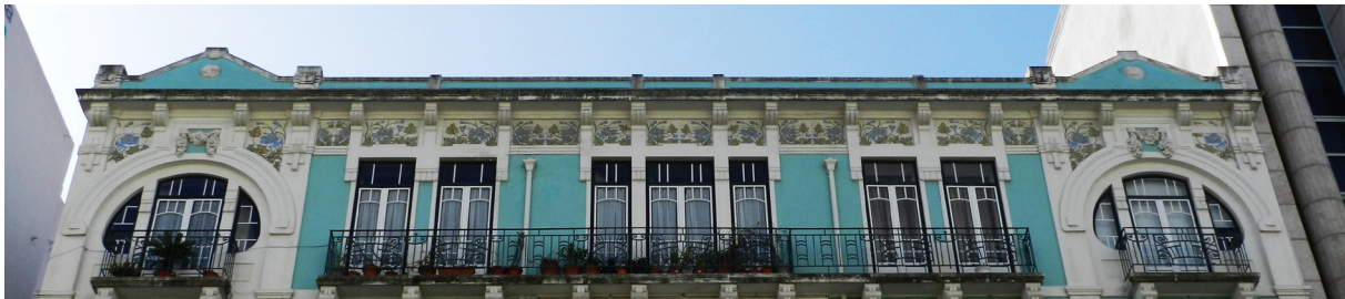
Fig. 81 - Remate do edifício. Organização dos painéis que forma uma faixa horizontal.
