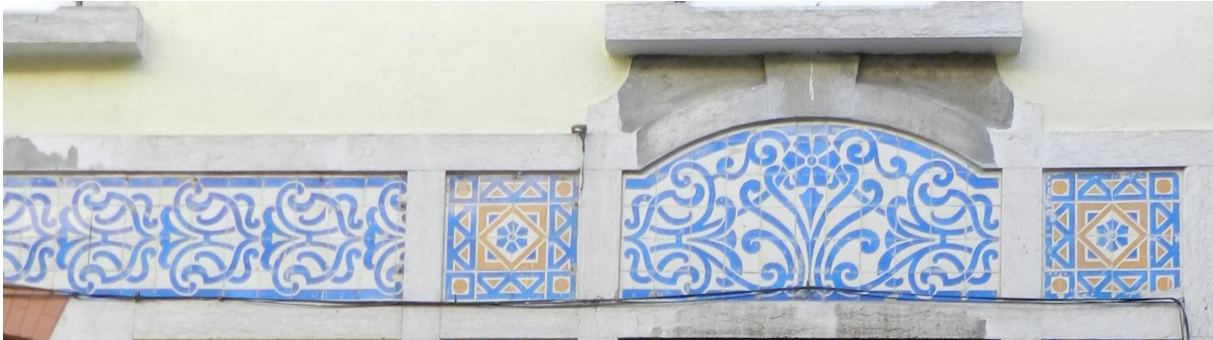
Fig. 211 - Edifício na Rua do vale do Pereiro - Pormenor do enquadramento da porta de entrada.
