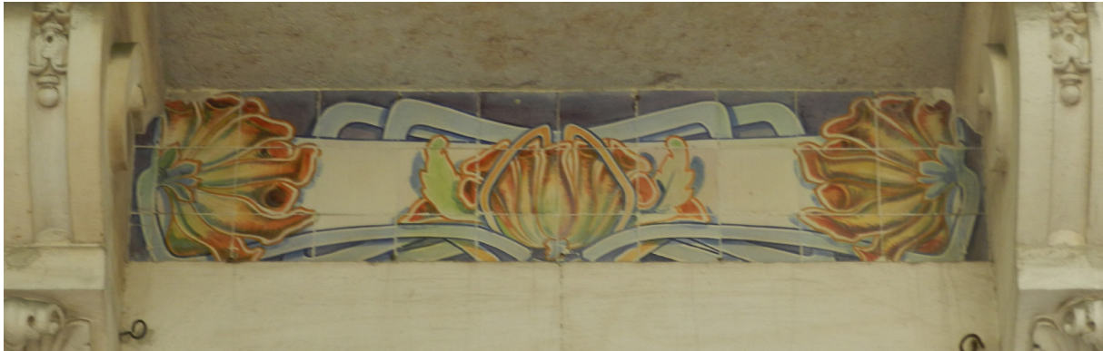
Fig. 196 - Painel central do conjunto de três, aplicado entre as mísulas da varanda do segundo piso.
