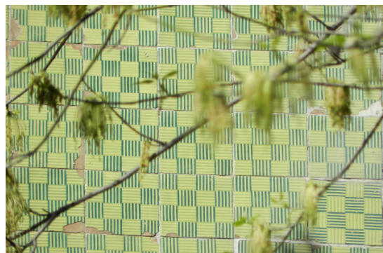
Fig. 261 - Destacamento do vidrado. Avenida João Crisóstomo nº 20.
