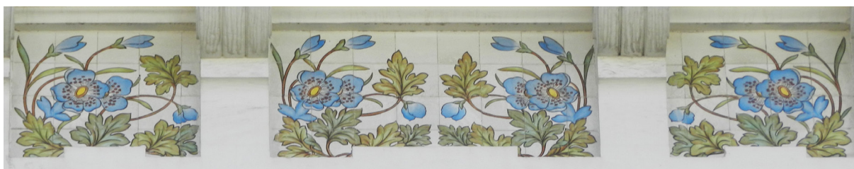
Fig. 82 - Pormenor dos painéis aplicados sobre as vergas das janelas de sacada centrais.
