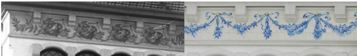
Fig. 115 - Do lado esquerdo, versão original do friso da cimalha do corpo localizado a nascente, recuado em relação ao corpo central e do lado direito a versão realizada em azulejo.
