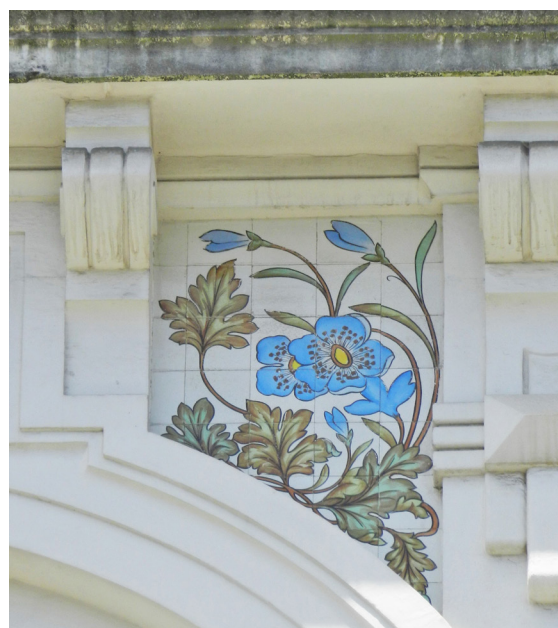
Fig. 83 - Vão de verga curva de um dos extremos da fachada. Organização dos painéis de azulejos acompanhando a curva da cantaria.
