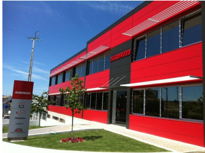
Figura 12 – Sede da SRAMPORT – Transmissões Mecânicas, Lda. (Imagem do autor)
