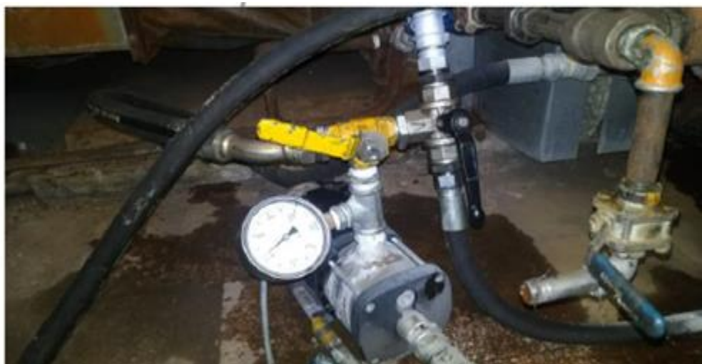
Figura 11 - Posicionamento final das válvulas de 3 vias
