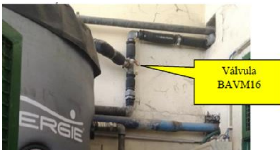
Figura 9 - Válvula de saída dos reservatórios
