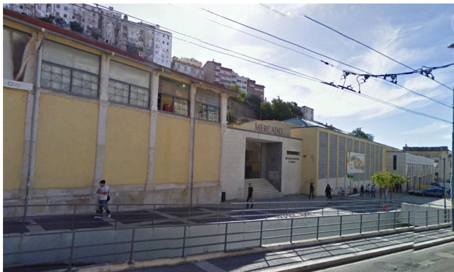
Figura 2.4. Pavilhão do Mercado Atualmente (Google a, 2013)
