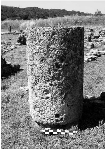
Figura 118 – Pilares de suporte de pavimentos de mezaninos (ínsula do vaso fálco e casa dos esqueletos).
