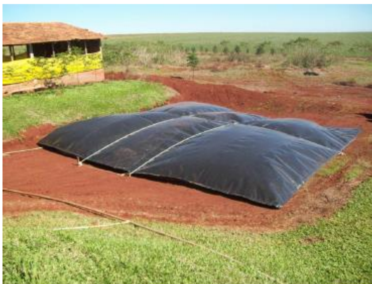
Figura 4.9 – Balão de armazenamento de biogás (Alves, et al., 2010)
