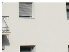
Material edificio (mortero blanco)
