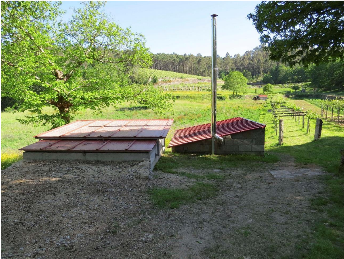
Fig. 226: Zona de descarga del camión. Fuente: Imagen aportado por Enertra.
