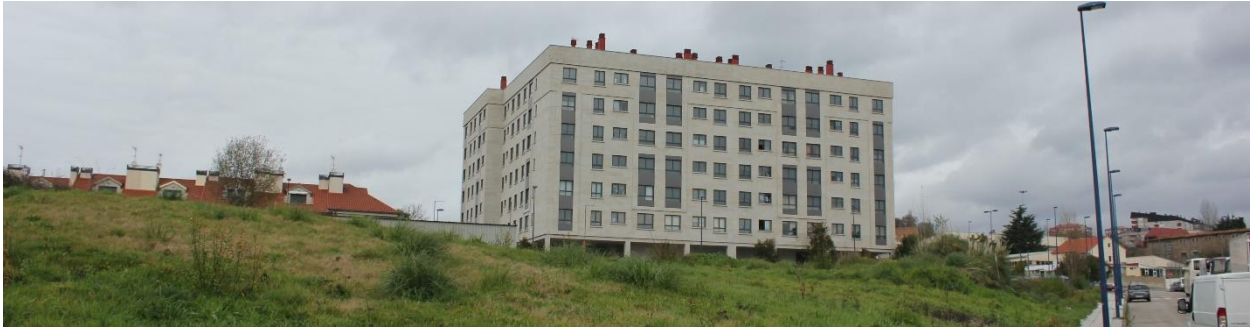
Fig. 101 Fachada principal del edificio de 96 viviendas ubicado en Vigo.
