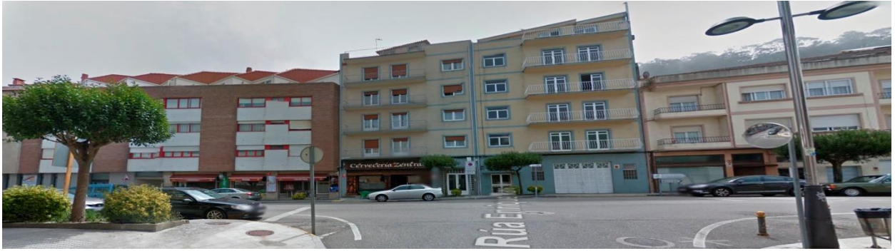
Fig. 85: Fachada del edificio de 10 viviendas ubicado en la Guardia.
