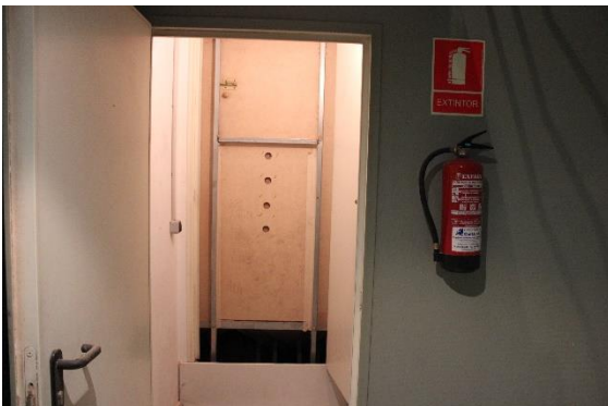
Fig. 192: Entrada al silo de obra.
