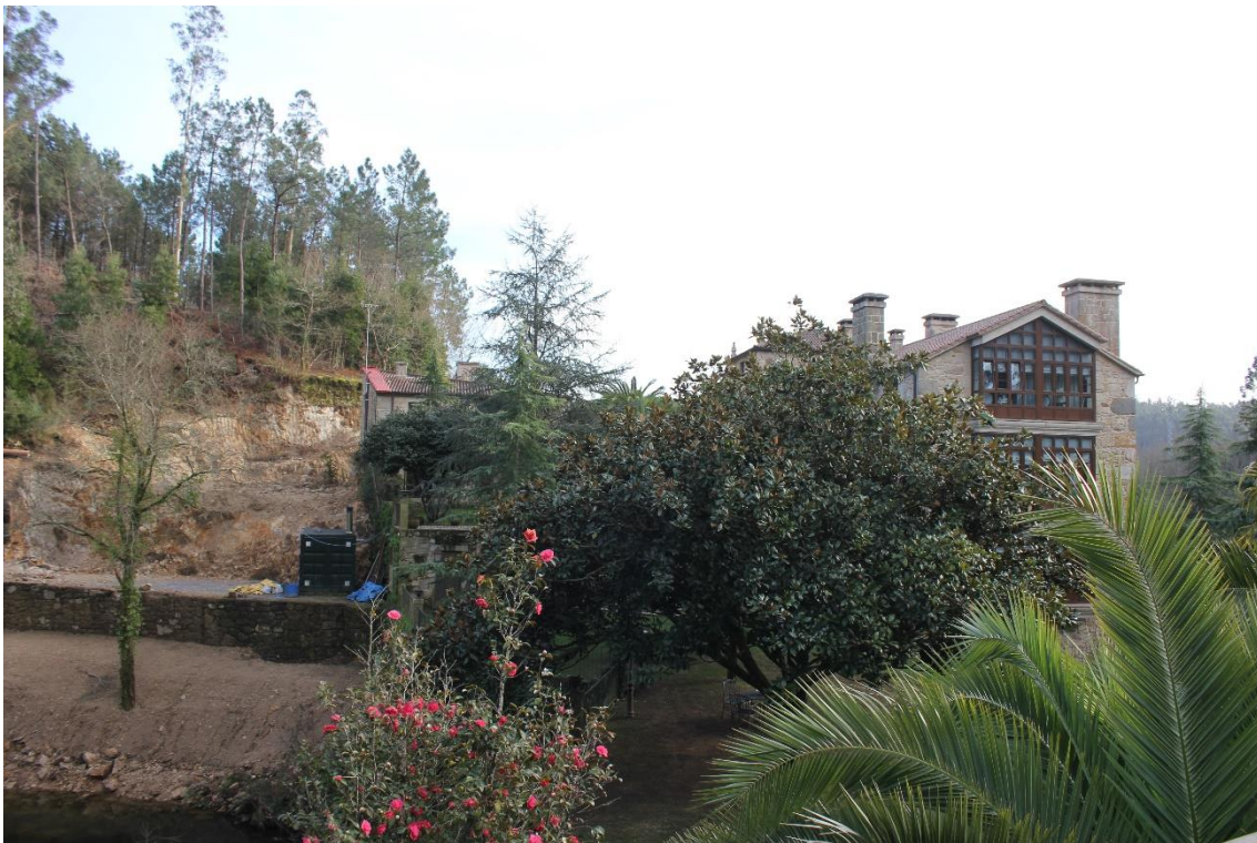
Fig. 230: Ubicación de la instalación de biomasa.
