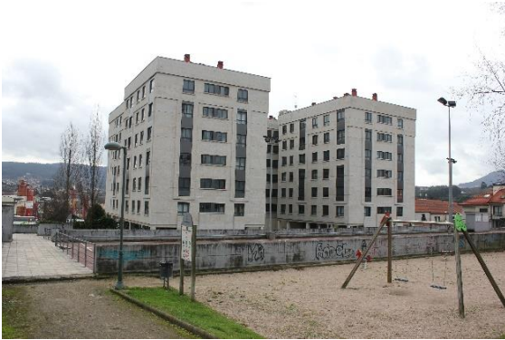
Fig. 188: Fachada norte del edificio.
