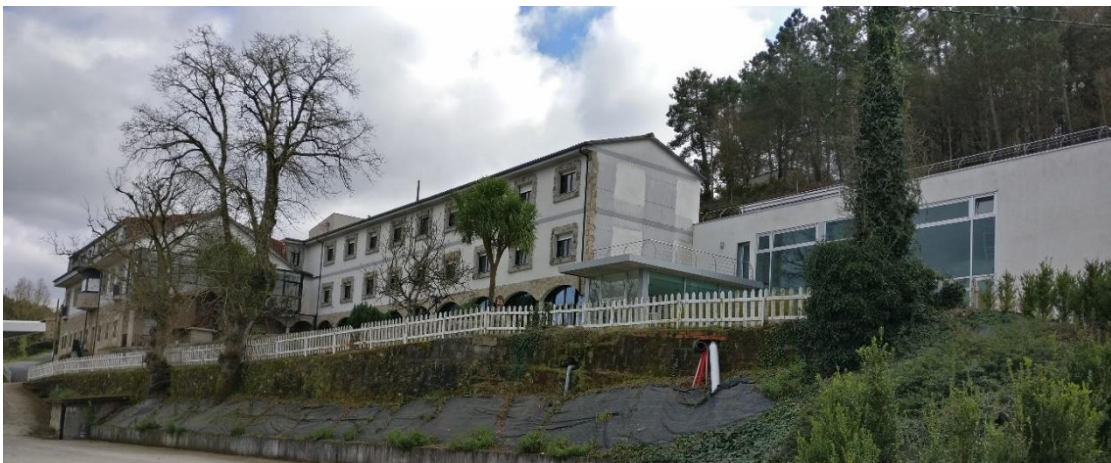
Fig. 213: Fachada del edificio.
