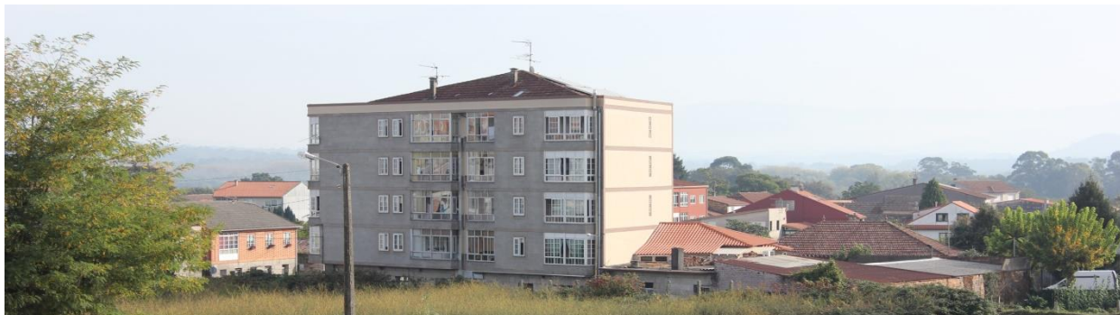
Fig. 95: Fachada trasera del edificio de 8 viviendas ubicado en Tui.
