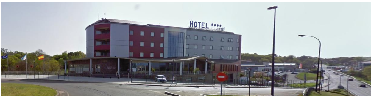
Fig. 147: Vista de la Fachada principal del hotel Torres do Deza.
