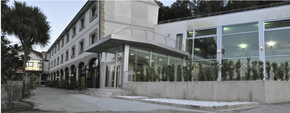
Fig. 125: Fachada Sur del Balneario Baños da Brea.
