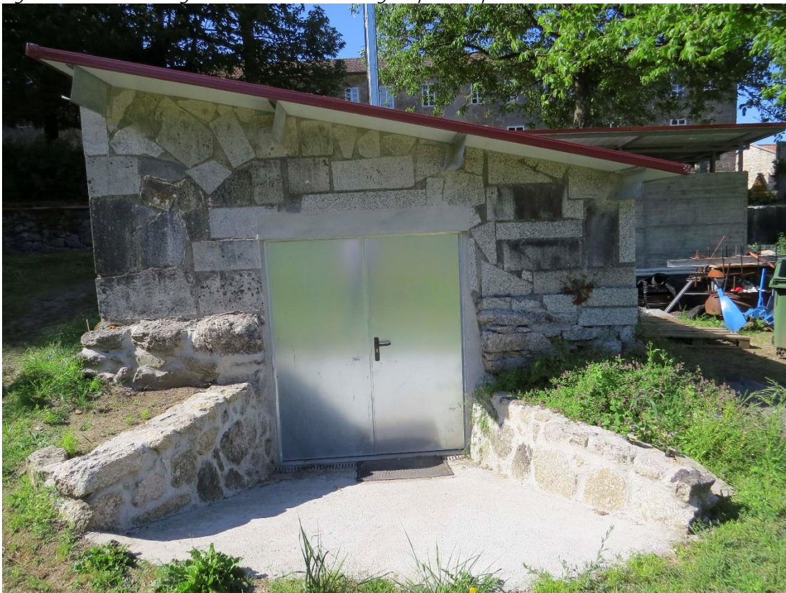
Fig. 227: Rehabilitación de un caseto en sala de calderas.
