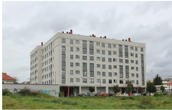
Fig. 189: Fachada sur del edificio.
