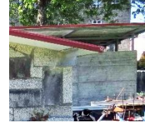
Material Almacén (piedra y hormigón)
