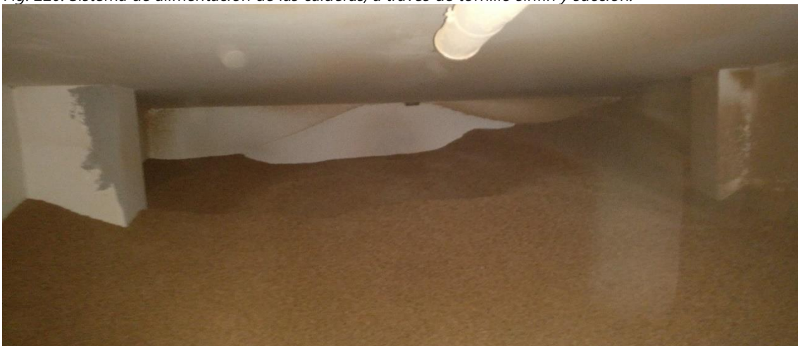
Fig. 221: Silo de obra de almacenamiento de pellets.
