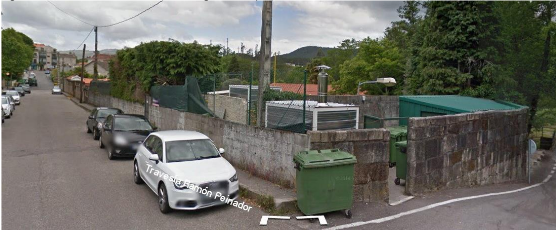
Fig. 204: Estado de las instalaciones térmicas anterior a la rehabilitación.
