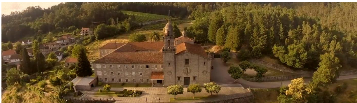
Fig. 152: Vista aérea de la Hospedería San Diego de Canedo.
