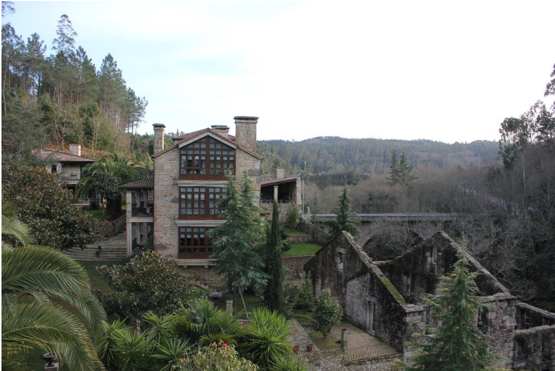
Fig. 229: Fachada principal del edificio.
