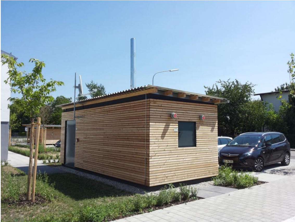
Fig. 30: Instalación de biomasa en un contenedor marítimo.
