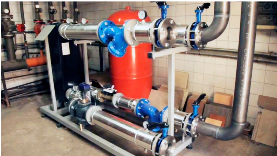
Fig. 26: Equipamiento para la adhesión a la red de calor.
