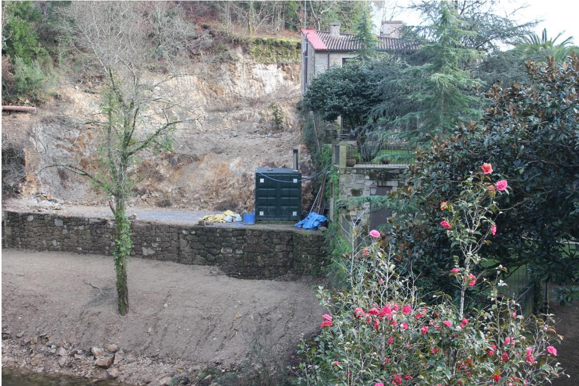
Fig. 231: Salida de humos de la instalación de biomasa.
