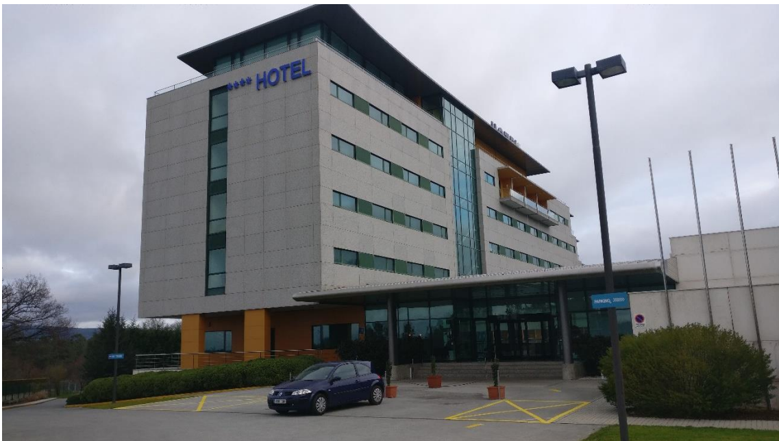
Fig. 225: Fachada del edificio.
