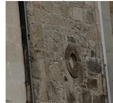
Material balneario (piedra granito)
