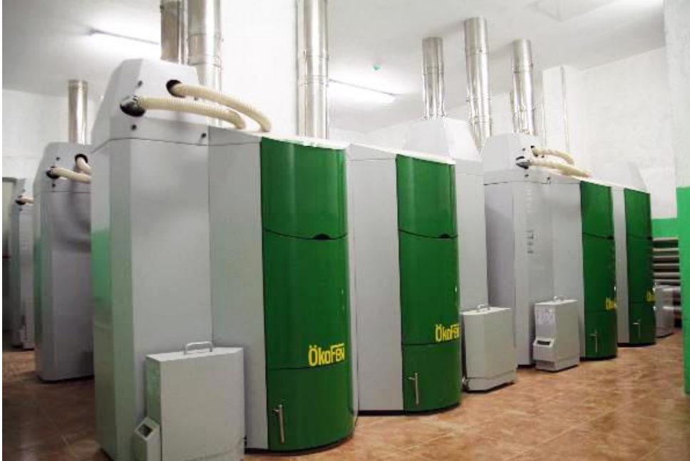
Fig. 27: Instalación de calderas de pellets Okofen.
