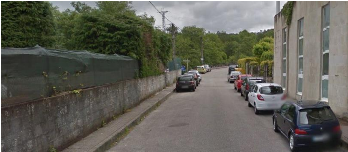
Fig. 208: Antigua acera de la fachada posterior del edificio baranda.
