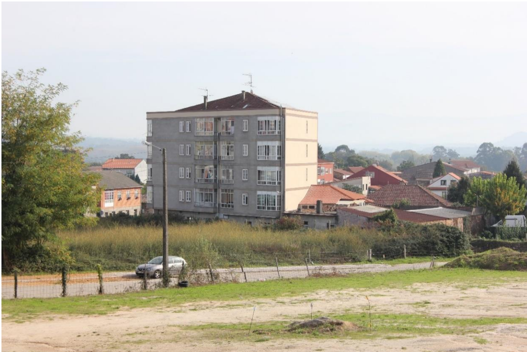
Fig. 187: Fachada oeste del edificio y chimenea de salida de humos.
