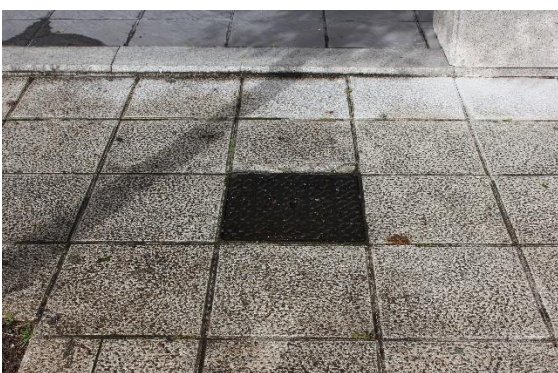
Fig. 194: Arqueta para descarga de pellets.
