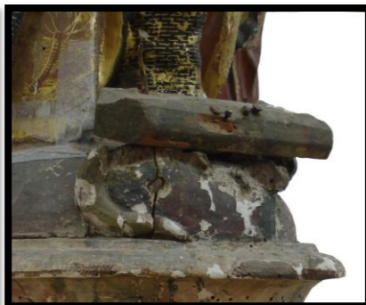
Fig. 56: elemento metálico fazendo a ligação dos dois blocos.
