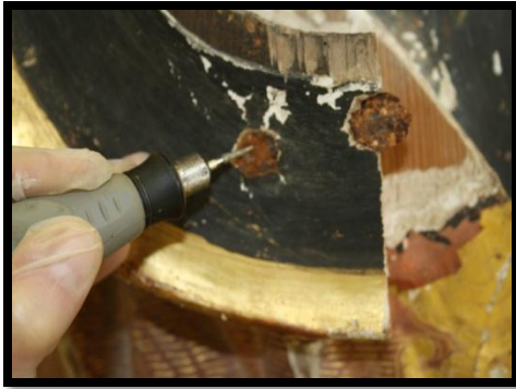
Fig.76: desoxidação de elementos metálicos.
