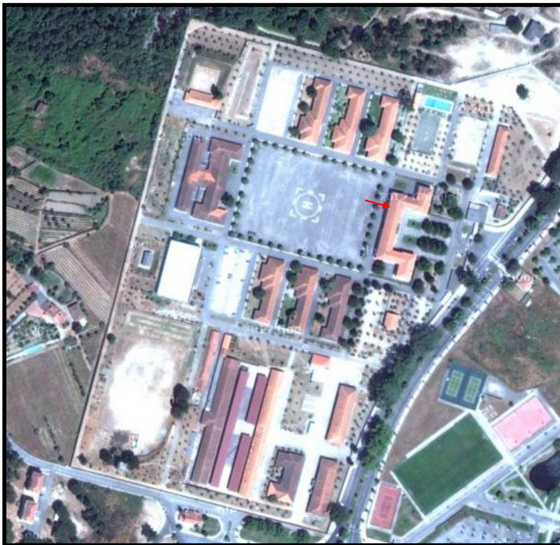
Fig. 25: vista aérea do Quartel do Regimento de Infantaria de Viseu, indicando o edifício onde se localiza o Núcleo Museológico. http://maps.google.pt/maps?hl=pt-PT&tab=wl .
