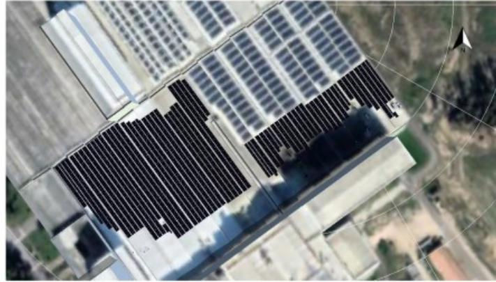
Figura 4.2: Imagem panorâmica 3D do parque fotovoltaico no telhado na fábrica da zona Centro Sul.
