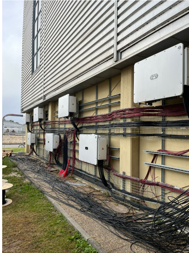
Figura 4.17: Inversores da central do telhado em processo de ligação.
