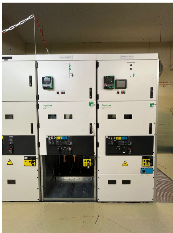
Figura 4.19: Celas do MCC onde ligam as PV Station da Central do Telhado e o PT3 da Central do solo - Sala na PM2.
