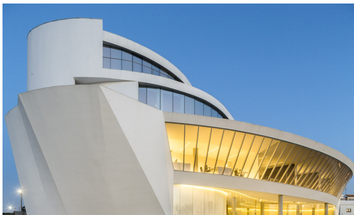
1. Edifício do CEiiA
