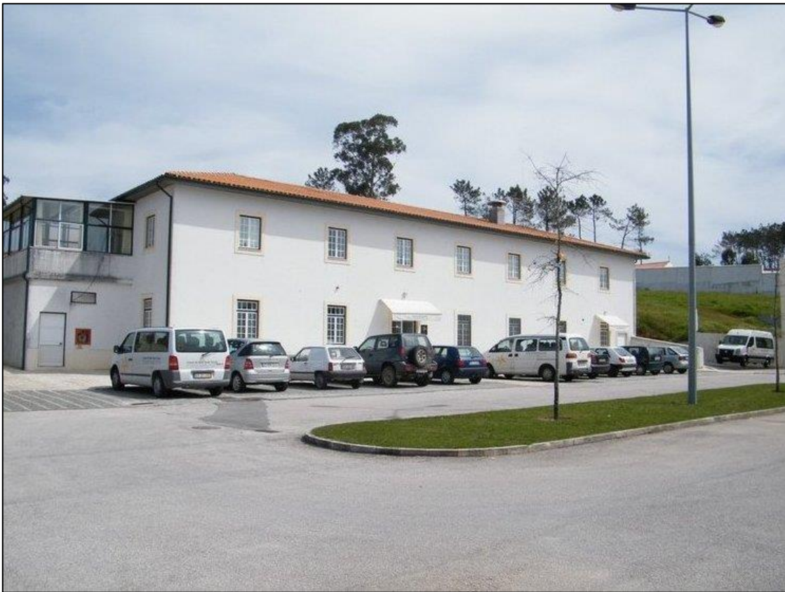
Figura 10 - Centro de Bem Estar Social da Freguesia de Figueira de Lorrvão
