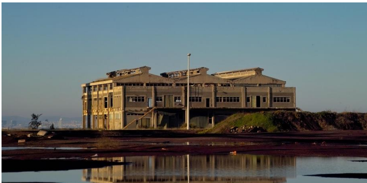
Fig. 36 - Infraestruturas degradadas (Google, 2016)
