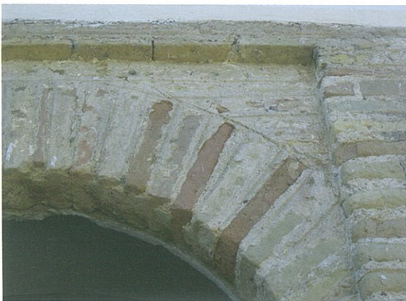
Fig. 3 - Pormenor do desenho com incisões do falso aparelho construtivo em porta da mesquita de Mértola
