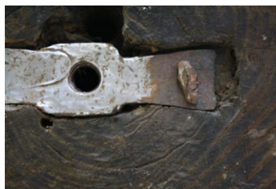
Figura 85 – Durante o processo de desoxidação
