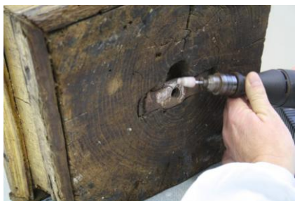
Figura 84 – Desoxidação do elemento metálico com mó abrasiva.
