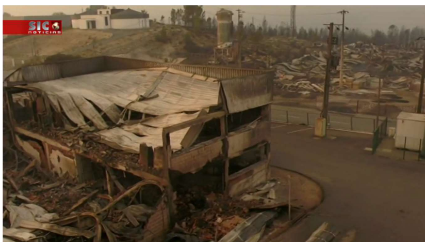
Figura 16 Instalações de empresas na Zona Industrial de Oliveira de Frades, atingidas pelos IF em outubro de 2017 (Sic Notícias)
