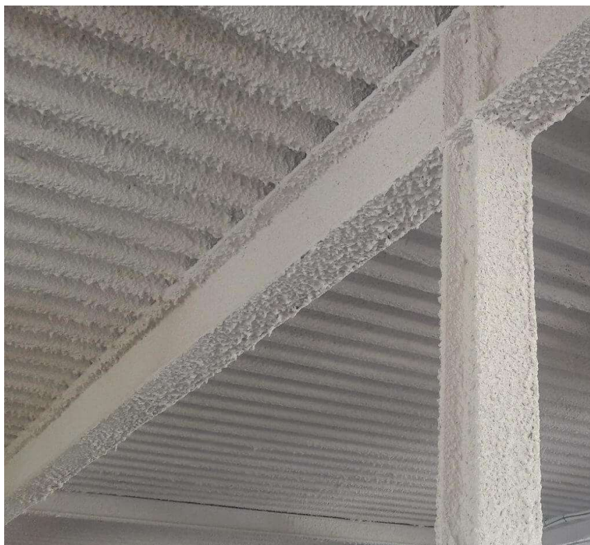
Figura 23 Aspeto final da proteção de elementos metálicos por projeção de argamassa (mercortecresa.com)
