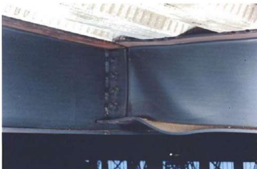
Figura 33 Encurvadura local do banzo inferior e dobragem da alma junto a uma ligação aparafusada (Maraveas, C. et al, 2015)
