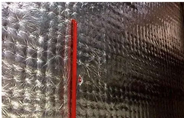
Figura 28 Manta cerâmica Fyrewrap Elite 1.5 (da Unifrax) utilizada como proteção contra fogo em nave industrial ( www.aecweb.com.br )
