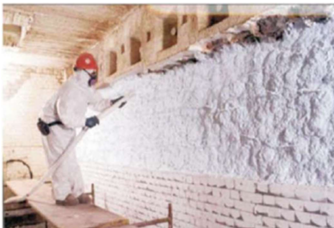
Figura 24 Aplicação de fibras projetadas (Soares, E., 2014)
