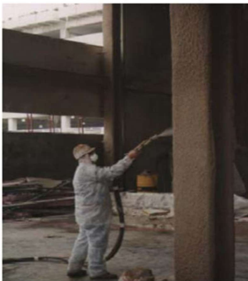
Figura 22 Aplicação de argamassa projetada em pilar (Soares, E., 2014)
