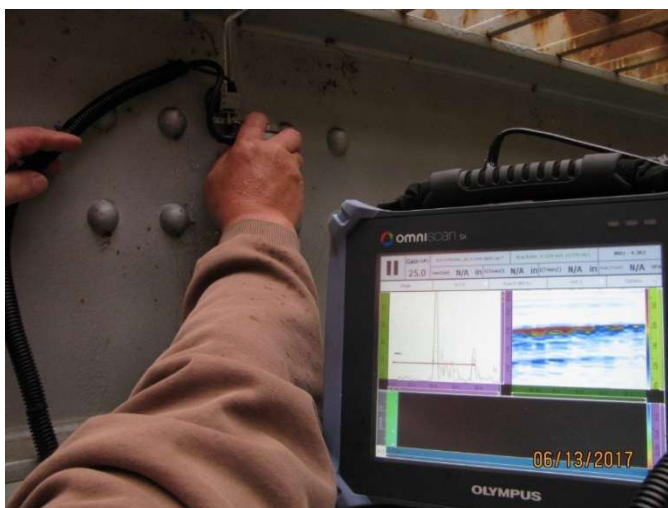
Figura 45 Inspeção ultrassónica em elemento de estrutura metálica (mtransportationresearch.org)
