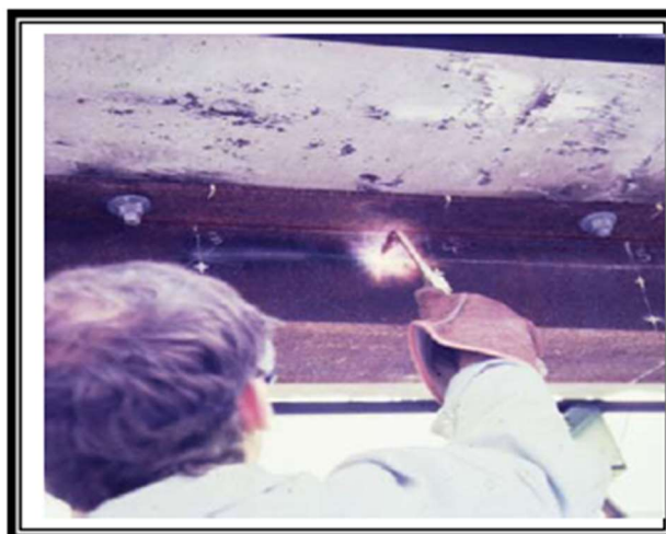
Figura 57 Execução de aquecimento em linha na alma de uma viga (FHWA, 2008)
