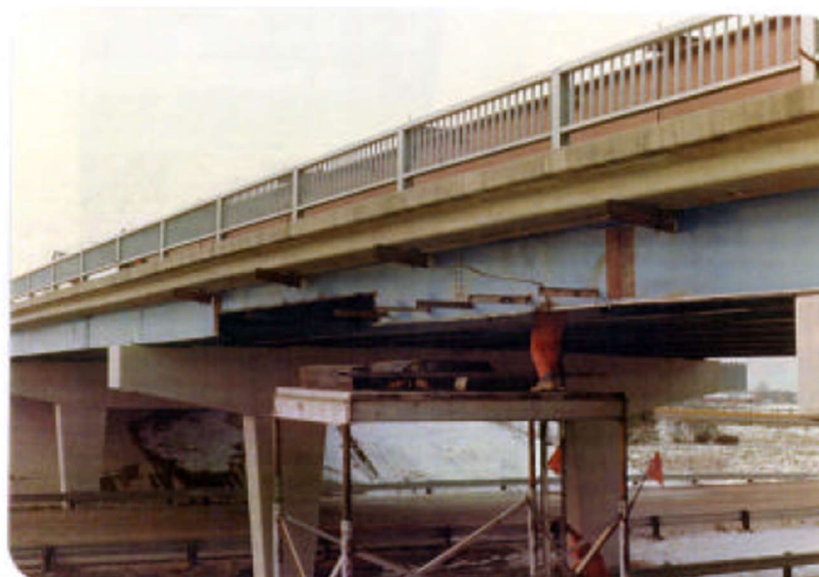
Figura 69 Corte da secção T inferior da viga de uma ponte com vista à sua substituição parcial (Alberta Transportation, 2004)
