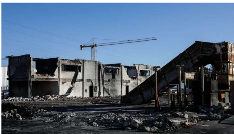
Figura 7 Instalações da empresa Tratis, em Tondela, atingidas pelo IF de outubro de 2017 (Observador)
