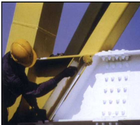
Figura 29 Aplicação de tinta intumescente (Soares, E., 2014)
