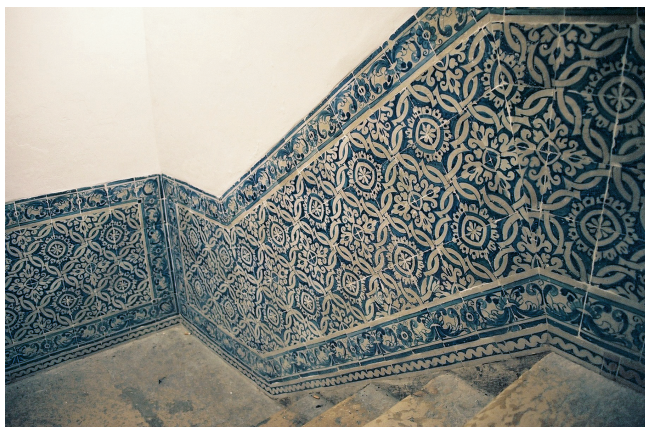
Silhares de azulejos de padrão, final do século XVII, escada do edifício na Rua da Rosa, n.ºs 269-277
