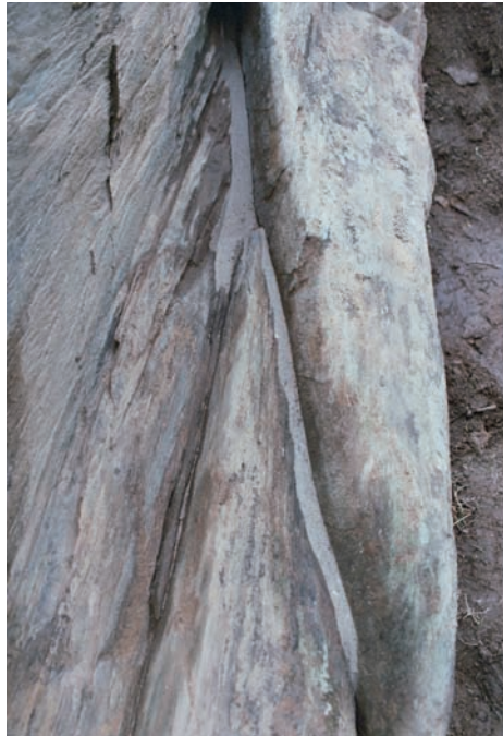
fig. 45 Aspecto da Rocha Tipo mostrando a mesma diaclase com preenchimento de argamassa.
