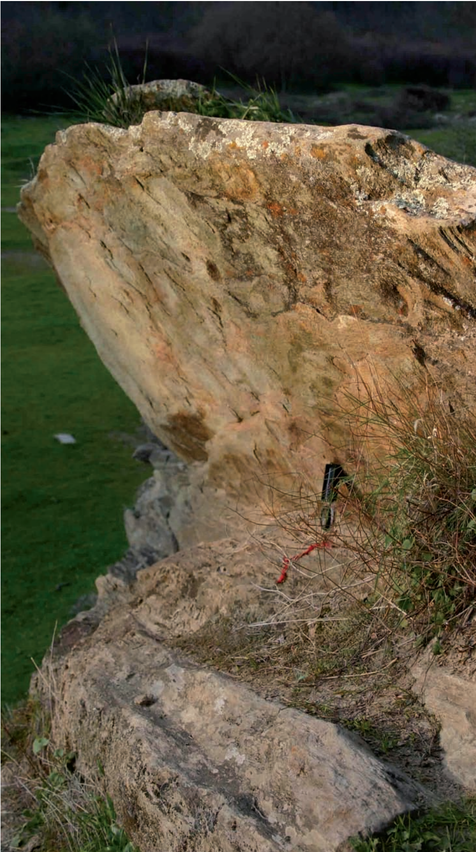
fig. 30 Acima do local da rocha 5, observa-se uma camada em consola, com inclinação propícia para basculamento.
