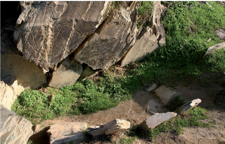
fig. 33 Travamento dos blocos da base, aspecto mais a S.
