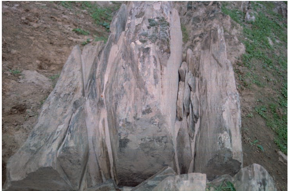
fig. 46 Aspecto da rocha Tipo depois da intervenção, observando-se a abertura das diaclases preenchidas com argamassas de cal Lafarge e Ledan C30.
