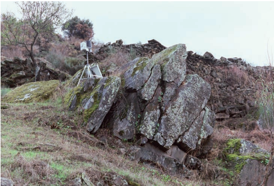
fig. 7 Aspecto geral da rocha monitorizada. Observam-se as três famílias de diaclases ortogonais que cortam o afloramento, definindo paralelepípedos.
