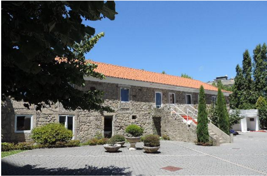
Figura 5 – Fundação Conservatório Regional de Gaia
