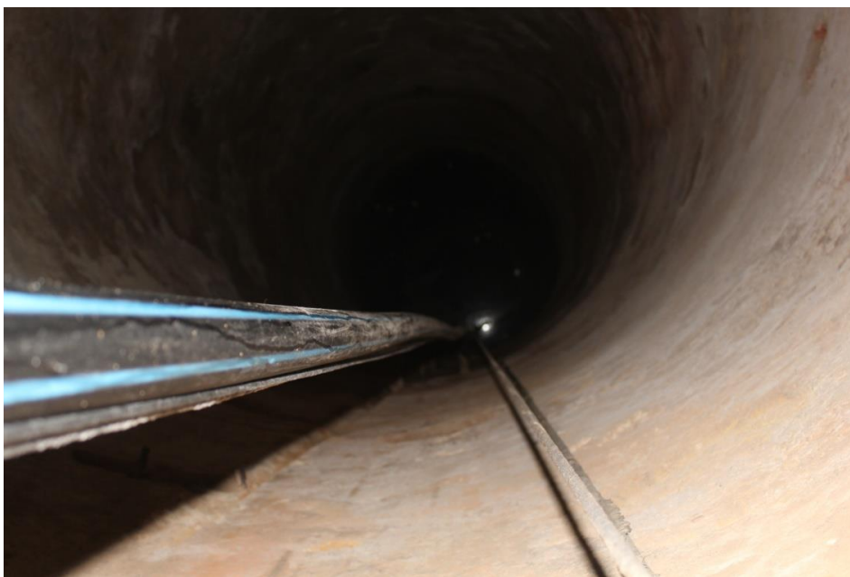
Fotografia 6 - Poço, fonte de abastecimento para rega e agricultura (Fonte: Autor 2016)
