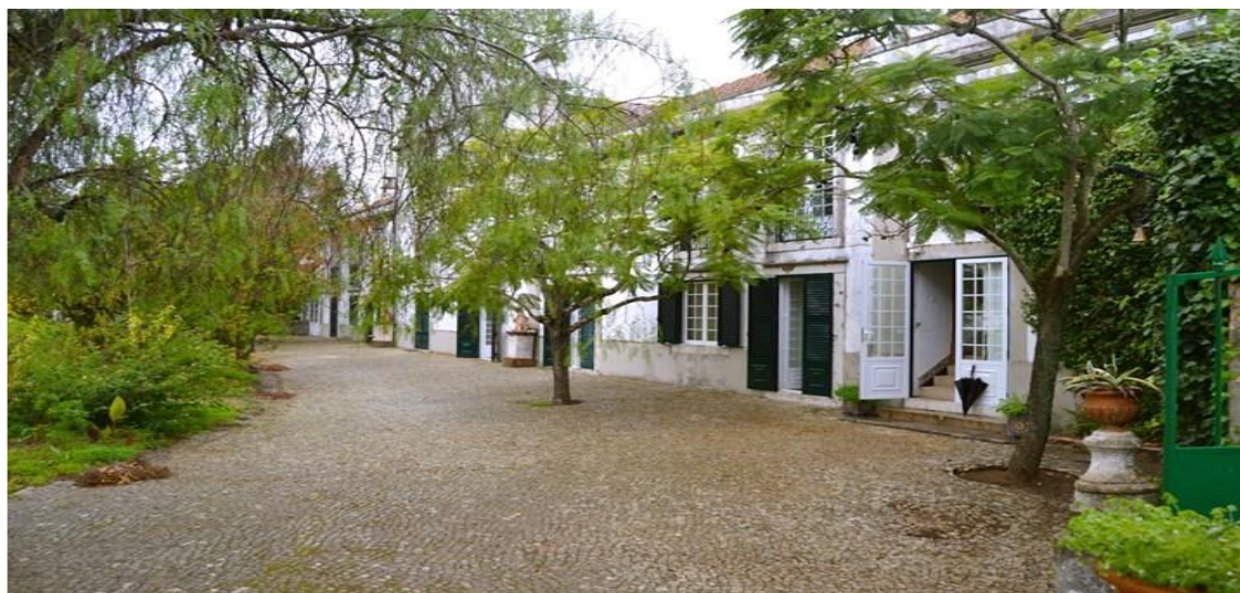
Fotografia 3 - Fachada Principal (Fonte: Autor 2015)
