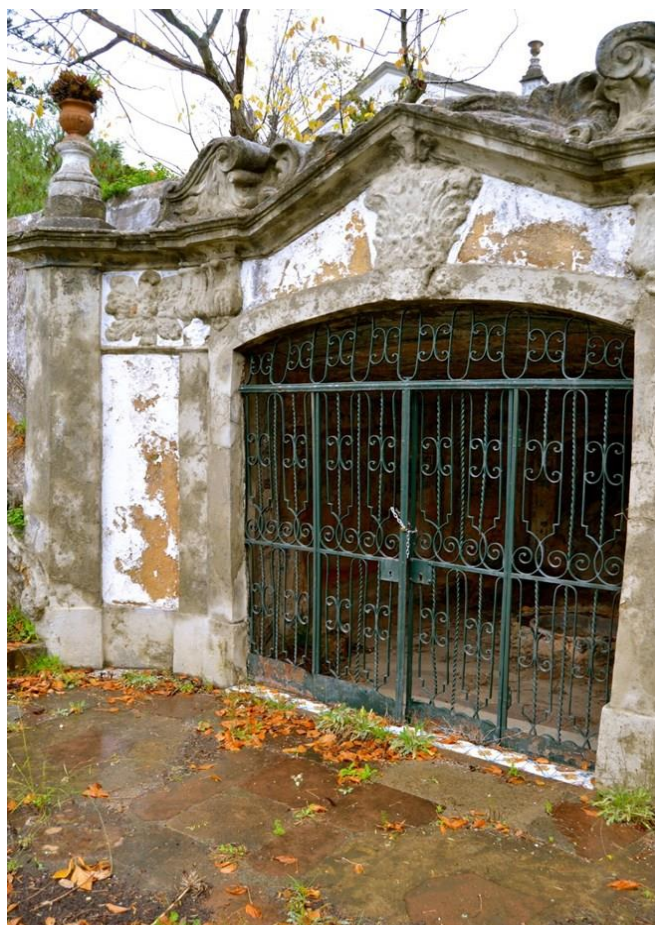
Fotografia 11 - Exterior da gruta (Fonte: Autor 2015)
