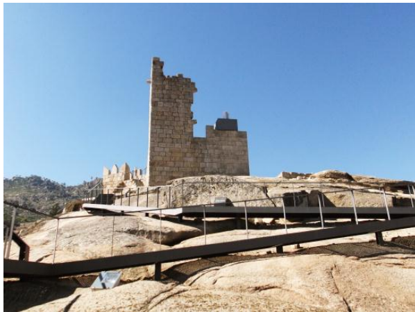
Figura 7.103. Vista da plataforma a partir da torre do relógio, 2013. Fotografia da autora.
