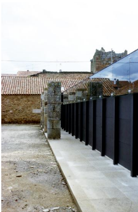
Figura 4.5. Arquivo situado no logradouro do lagar, Idanha-a-Velha, s/d. Autor: Luís Ferreira Alves.
