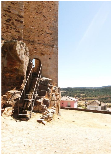
Figura 7.9. Porta existente no troço do paço adossado à torre de menagem, 2013. Fotografia da autora.
