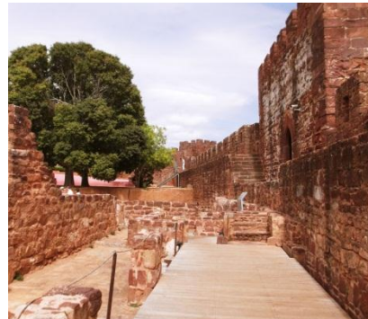
Figura 7.186. Passadiço do circuito de visita, 2013. Fotografia da autora.
