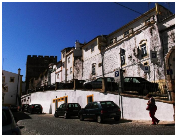
Figura 7.157. Vista de uma das torres, 2013. Fotografia da autora.
