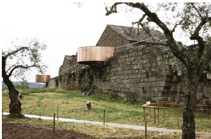
Figura 4.3. Passadiço com alusão aos cubelos pré-existentes, Idanha-a-Velha, s/d. Autor: Luís Ferreira Alves.
