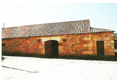
Figura 4.7. O edifício do lagar depois da intervenção, Idanha-a-Velha, s/d. Autor: IPPAR.
