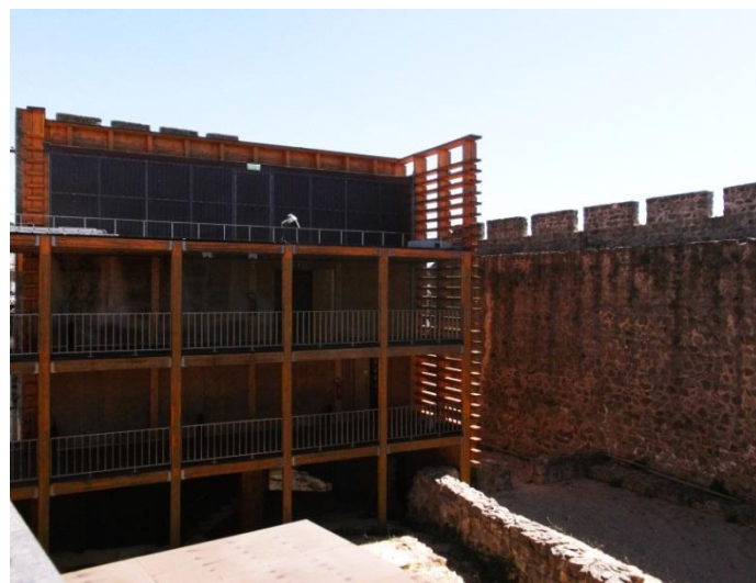
Figura 7.163. Vista das galerias no espaço intramuros, 2013. Fotografia da autora.
