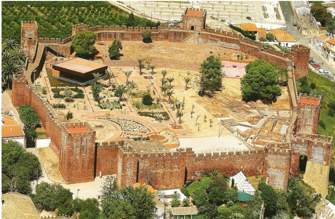
Figura 7.183. Vista aérea da intervenção, s/d. Autor(es): FG+SG.
