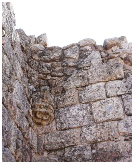
Figura 7.97. Arranque da abóboda, Torre de Menagem, 2013. Fotografia da autora.
