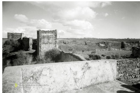
Figura 7.180. Castelo antes do restauro efectuado pela DGEMN, 1940. Autor desconhecido
