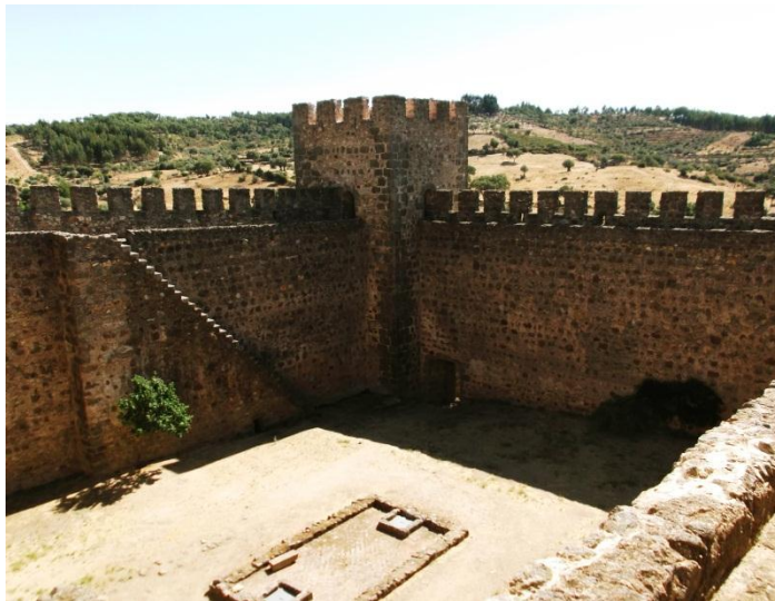
Figura 7.133. Vista, a partir da torre de menagem, do espaço intramuros com cisterna ao centro, 2012. Fotografia da autora.
