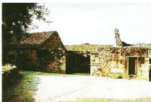
Figura 4.6. O edifício do lagar antes da intervenção, Idanha-a-Velha, s/d. Autor: IPPAR.
