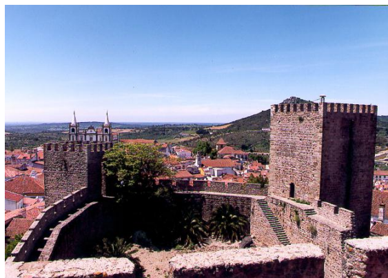
Figura 7.153. Castelo, antes da intervenção, s/d. Autor desconhecido.
