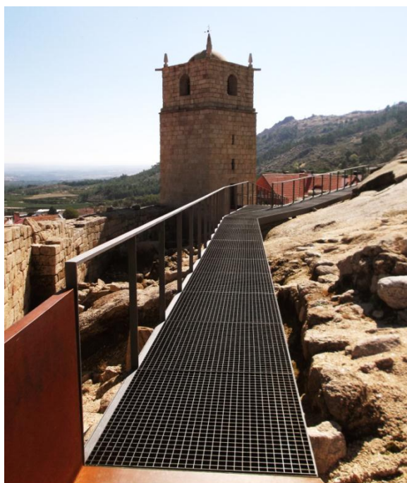
Figura 7.100. Plataforma existente no espaço intramuros, 2013. Fotografia da autora.
