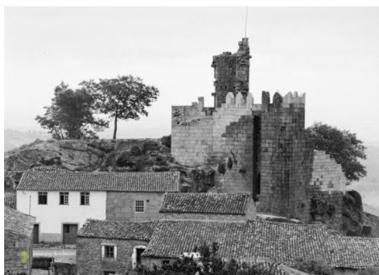
Figura 7.94. Castelo, após a reconstrução efectuada pela DGEMN, s/d. Autor desconhecido.
