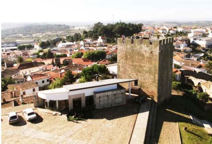
Figura 4.24. Fotografia da cafetaria e torre sul do castelo de Pinhel, 2013. Fotografia da autora.
