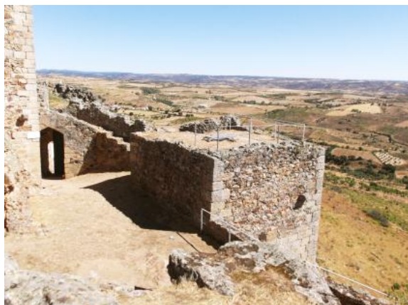
Figura 4.32. Protecção do adarve no castelo de Algosó, 2013. Fotografia da autora.
