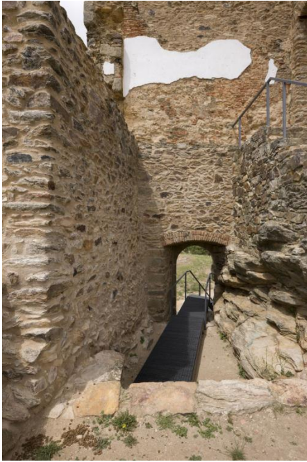
Figura 7.13. Acesso a partir do vão existente no troço de parede do paço, s/d. Autor: Luís Ferreira Alves.
