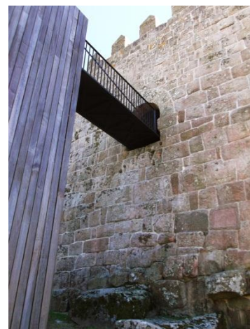
Figura 7.39. Escada de acesso à torre de menagem, 2013. Fotografia da autora.
