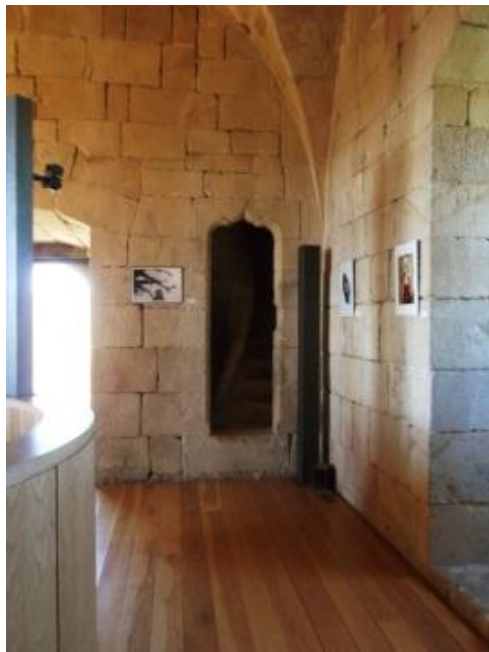
Figura 4.28. Escadas de acesso à cobertura da torre norte do castelo de Pinhel, 2013. Fotografia da autora.
