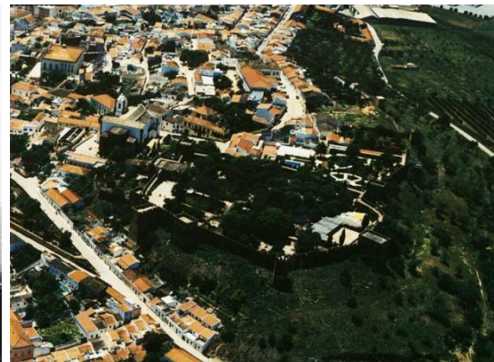
Figura 7.182. Castelo, antes da intervenção mais recente, s/d. Autor desconhecido.
