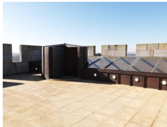
Figura 4.26. Fotografia do acesso à cobertura da torre sul do castelo de Pinhel, 2013. Fotografia da autora.
