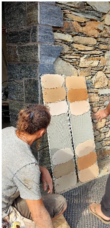
Figura 36 – Protótipo - 2C. Rebocos e acabamentos naturais no Eco-Hostel em Ananda Kalyani
