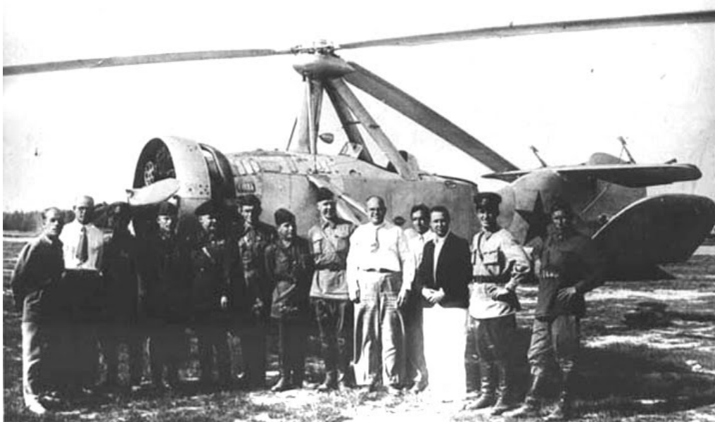
Figura 13: Um auto-giro Kamov A-7, a primeira aeronave desse tipo concebida para o combate armado, e capaz de descolagens muito curtas e aterragens quase verticais. (Gunston 2000).
