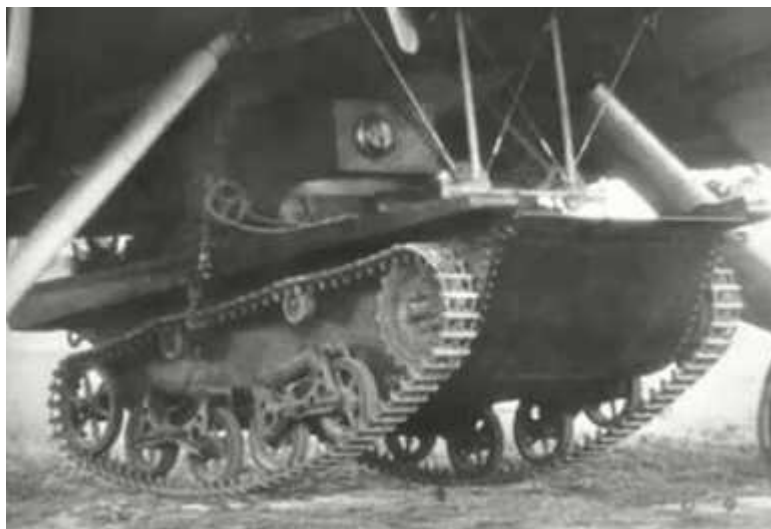
Figura 4: Um T-37 transportado sob um TB-3 para transporte aéreo. As ideias de Tukhachevsky para a mecanização das unidades aerotransportadas deram origem a extensas experiências.
