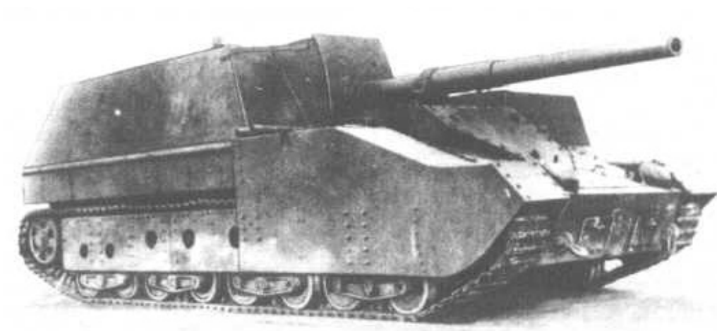
Figura 9: Uma peça auto propulsada Su-14-2 de 152mm. Os soviéticos experimentaram intensamente com artilharia autopropulsada nos anos 30, incluindo calibres pesados da artilharia de Corpo de Exército.
