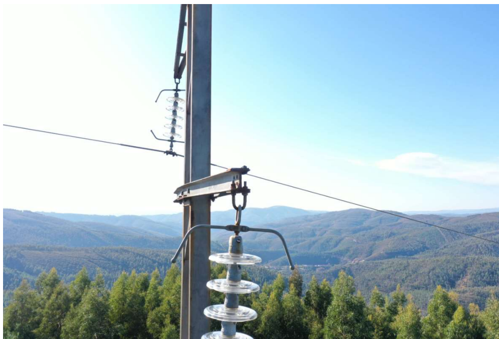
Figura 41 – Visualização de cadeia de isoladores de uma linha de MT [26]
