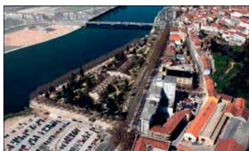
Figura 36 - Vista parcial da margem direita do Mondego antes da intervenção do Programa Polis
