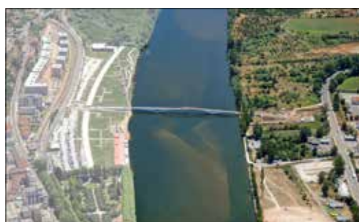
Figura 37 - Vista parcial da margem esquerda do Mondego antes da intervenção do Programa Polis
