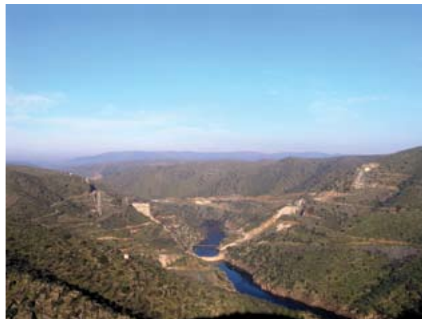
Fig. 3 – Estado actual das obras de construção da barragem de Vila Nova de Foz Côa.
