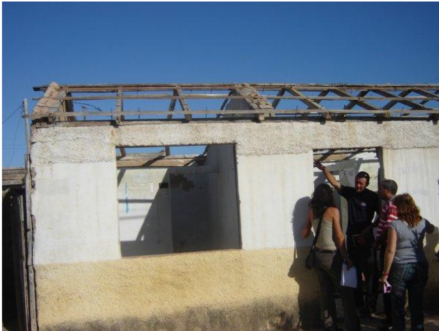
Figura 20. Assistência - Oikos. Apoio à população em Cuba no pós-furacão. Recuperação de infraestruturas 18
