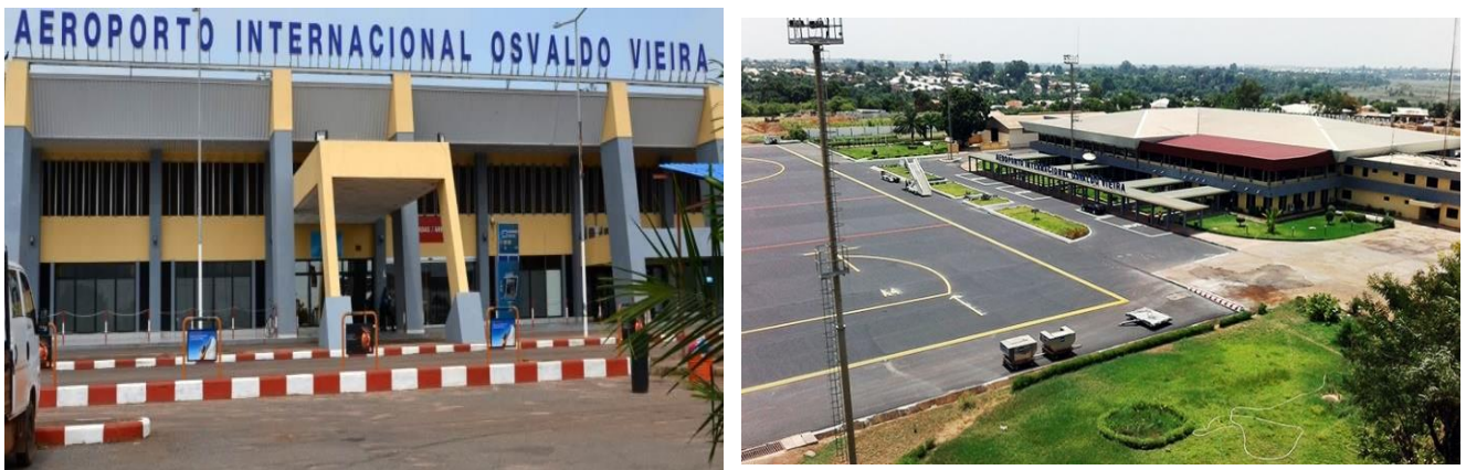
Figura 2. Vista Exterior e Lado Ar do AIOV. Fonte (AACGB, 2020).
