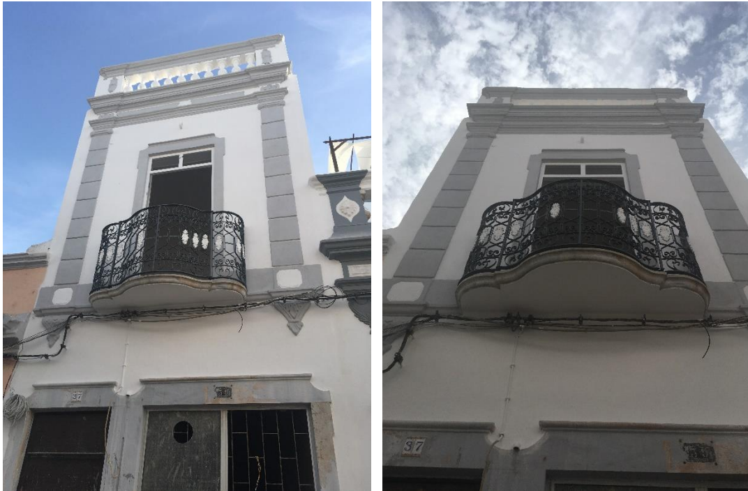
Figura 88 - Fachada e janela do quarto primeiro andar. (imagem nossa)
