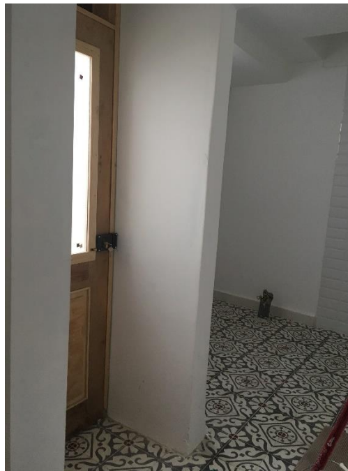
Figura 92 – Imagem casa de banho e porta para escada até açoteia no primeiro andar.
