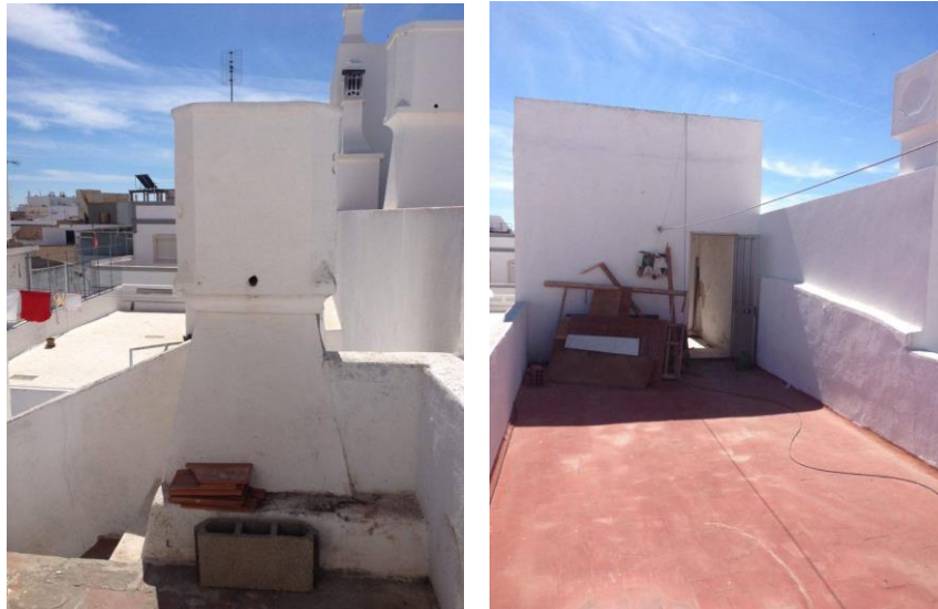
Figura 46- Imagens chaminé balão 21 e açoteia no segundo andar da casa em Olhão antes de renovação (imagem nossa)
