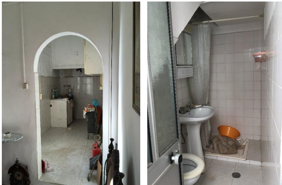
Figura 45 - Imagens cozinha e casa de banho de primeiro andar da casa em Olhão antes de renovação (imagem nossa)
