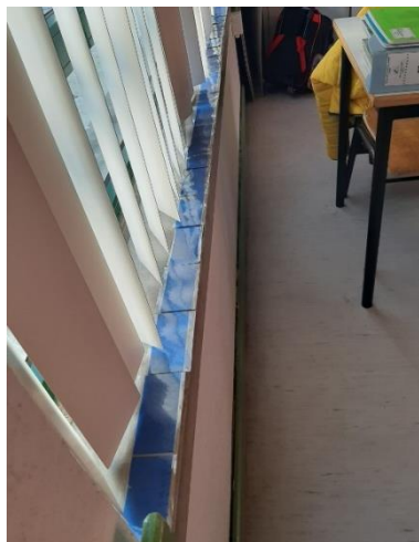
Figura 50 – Medição do parapeito da janela da sala de aula com tiras de cartolina
