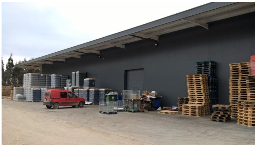
Figura 2 – Zona de recepção das matérias-primas e material de embalagem.
