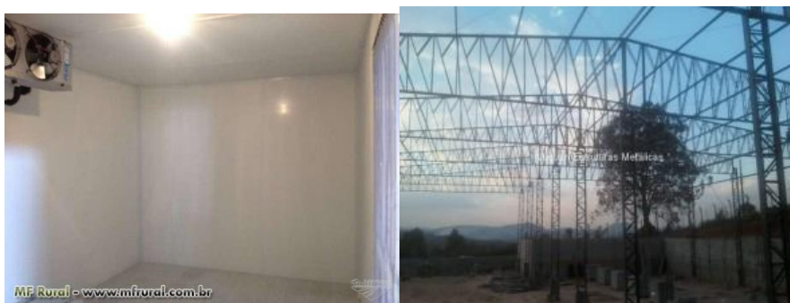
Figura 8 – Teto suspenso a uma estrutura metálica
