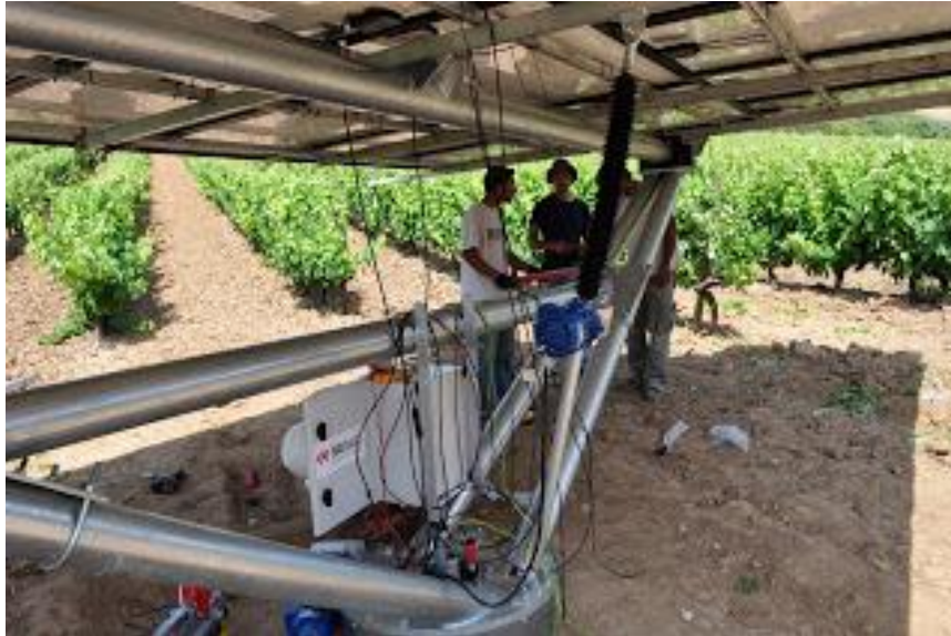
Figura 53: Imagem ilustrativa de um sistema seguidor depois de terminada a sua montagem, Fonte [19]
