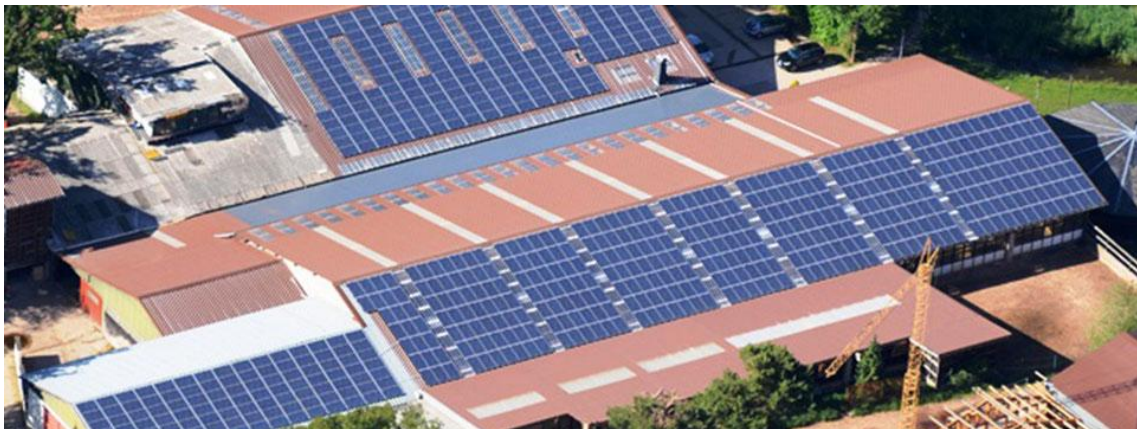
Figura 20: Fotografia do sistema fotovoltaico instalado pelo Grupo SINERGIAE na Alemanha, fonte: [34]
