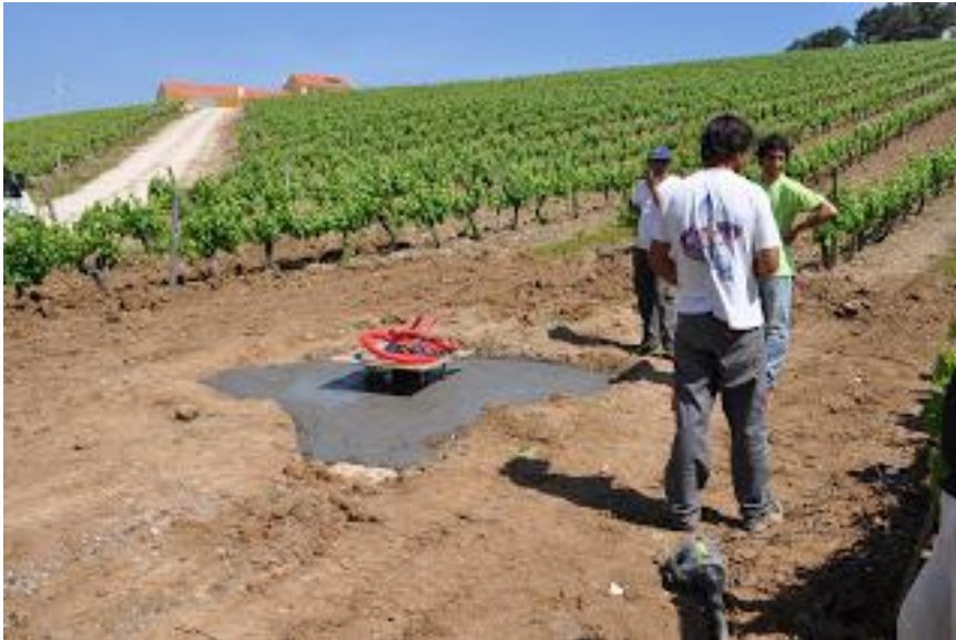
Figura 47: Imagem ilustrativa de uma sapata depois de terminada a sua construção, Fonte [19]
