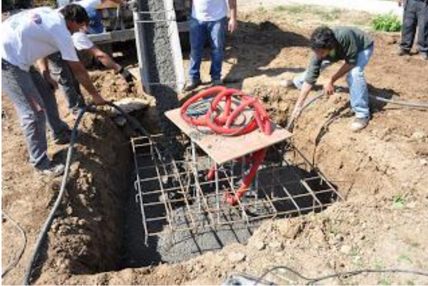
Figura 46: Imagem ilustrativa do enchimento de uma sapata, Fonte [19]
